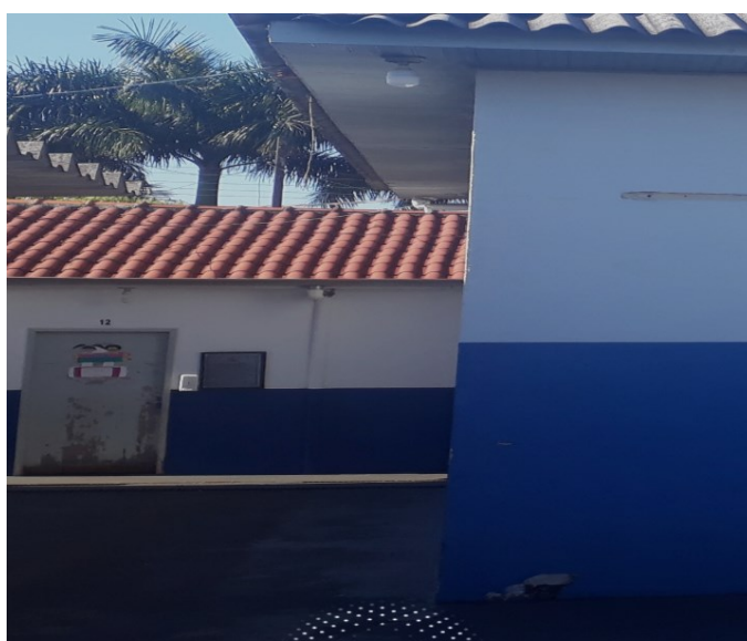
Figura 12. Bloco 3 e Bloco 1 da Escola.
