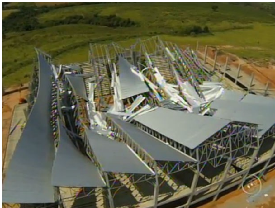
Figura 3 – Colapso estrutural em estádio de Sorocaba/SP
