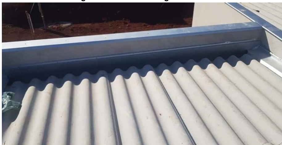
Fotografia 1 – Calha retangular instalada.
