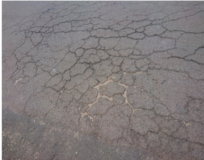
Fotografia 8 - Couro de jacaré no trecho 3
