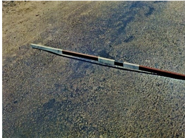
Figura 3 - Afundamento local
