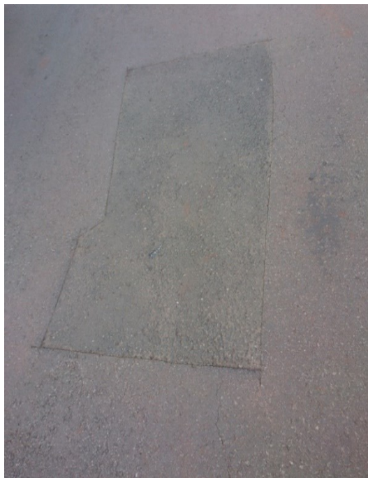
Fotografia 9 - Remendo no trecho 4
