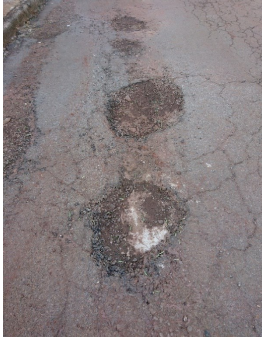
Fotografia 4 - Panela no trecho 2
