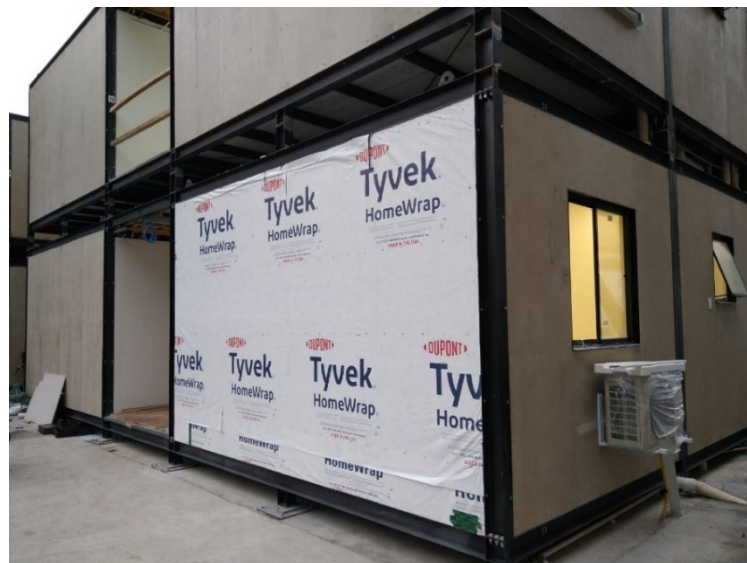
Figura 24 – Módulo acabado com vedação em Light Wood Frame
