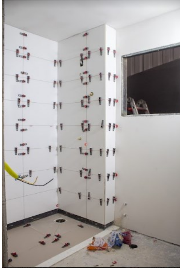
Figura 34 – Execução do revestimento cerâmico do banheiro
