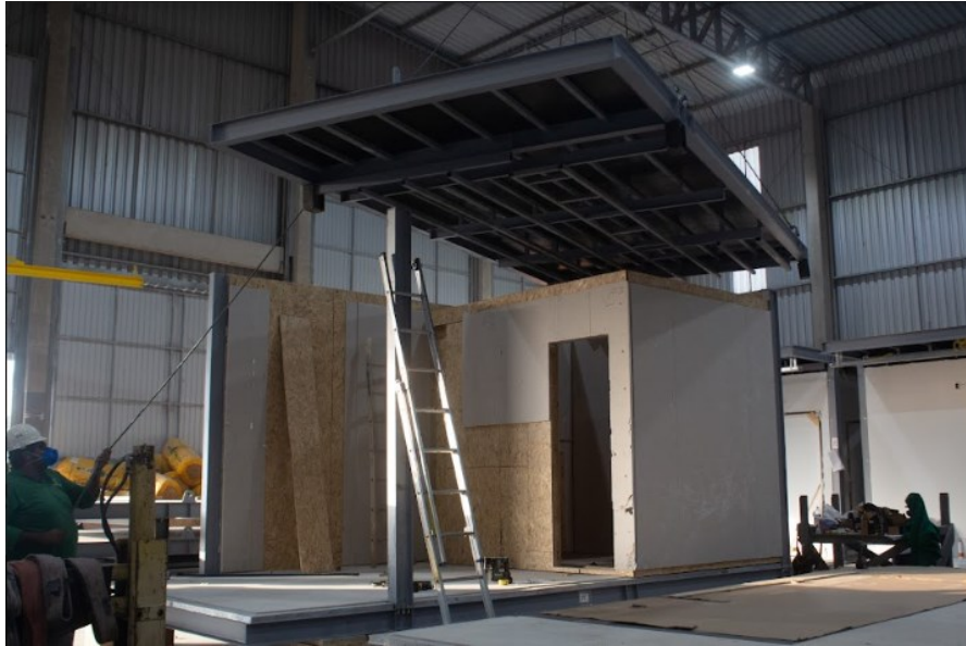
Figura 29 – içamento da estrutura do forro
