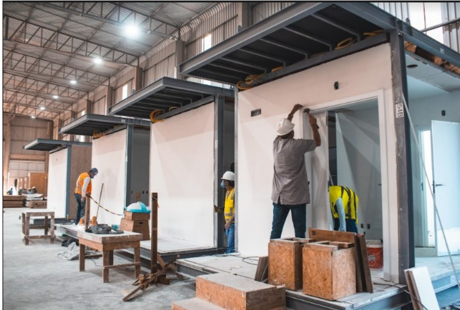
Figura 36 – Instalação das esquadrias de madeira
