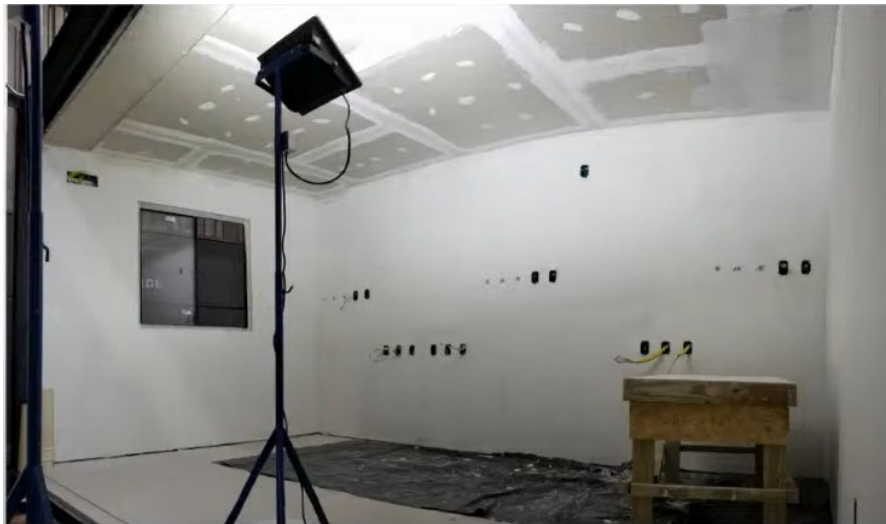
Figura 33 – Execução de tratamento de juntas do forro
