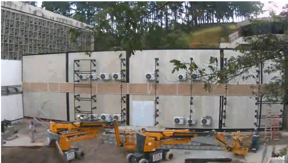
Figura 42 – Instalação e arremate de fachada externa
