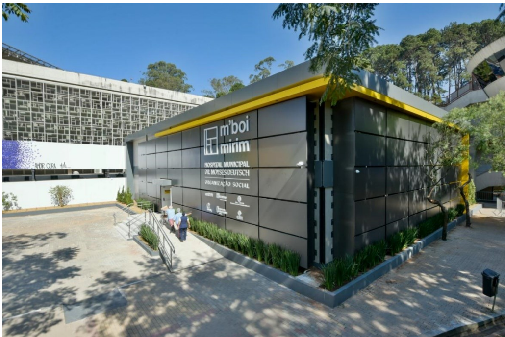
Figura 44 – Fachada do hospital M'Boi Mirim finalizada
