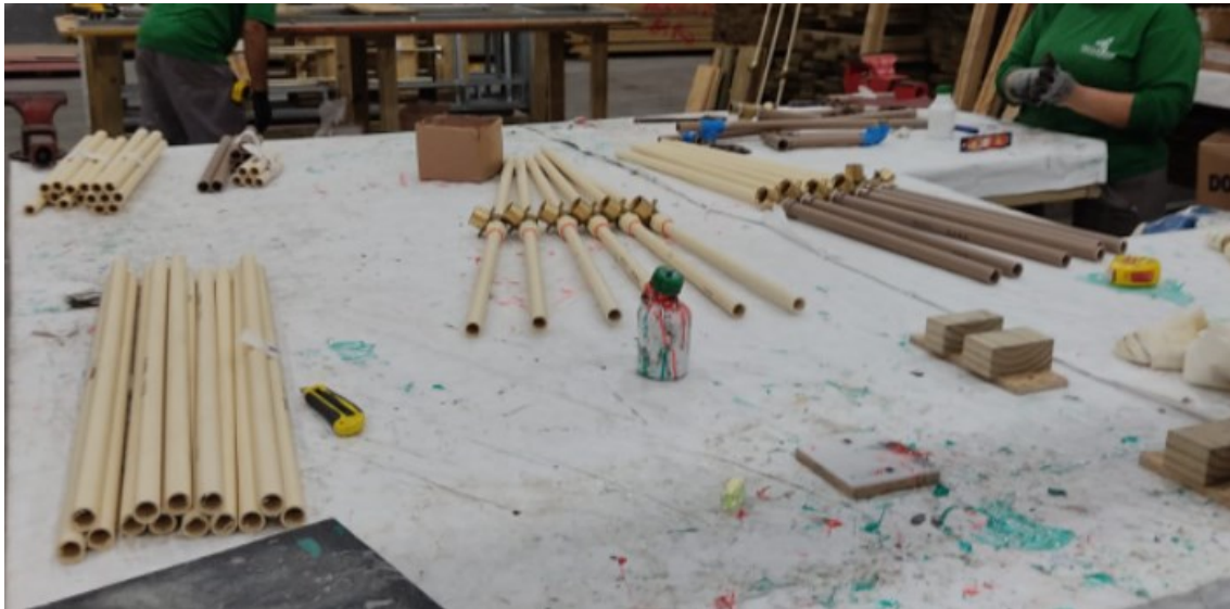
Figura 23 – Preparação das tubulações embutidas nas paredes
