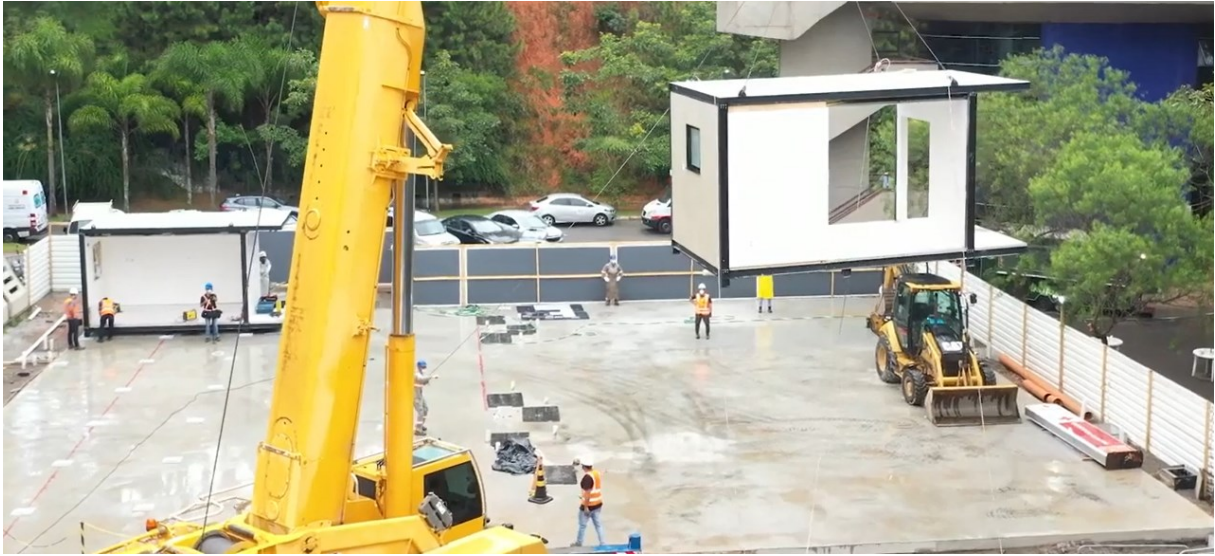
Figura 39 – Içamento dos módulos acabados em canteiro de obra
