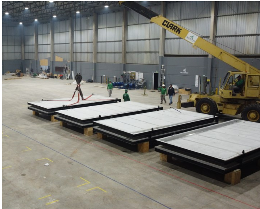
Figura 26 – Estrutura pré-fabricada do forro dos módulos com painel de fibrocimento
