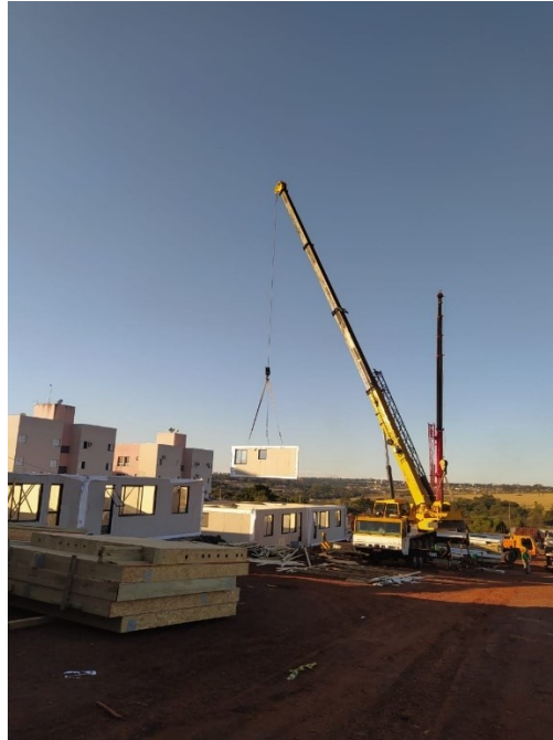
Figura 7 – Içamento de parede pré-fabricada de madeira
