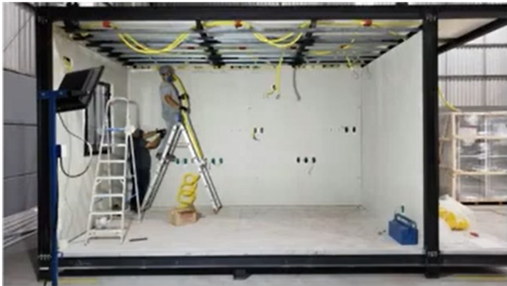
Figura 31 – Execução da instalação elétrica no módulo
