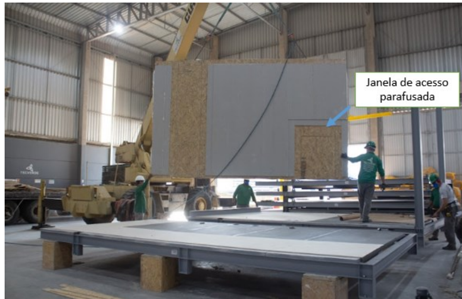
Figura 32 – Janela de acesso para ligação de tubulações no canteiro de obra
