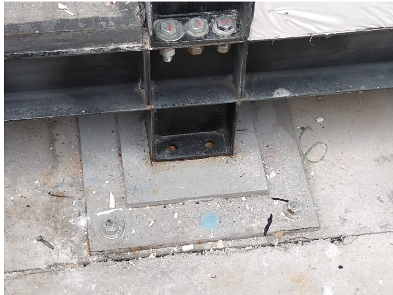
Figura 40 – Fixação do módulo na fundação
