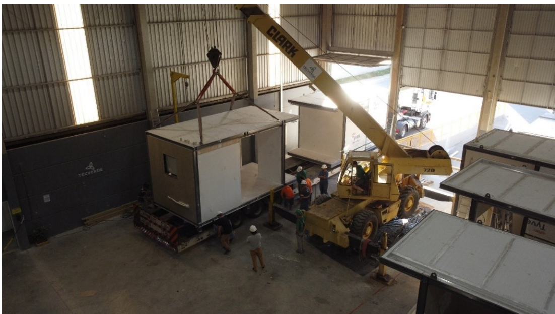
Figura 21 – Preparação dos módulos para transporte
