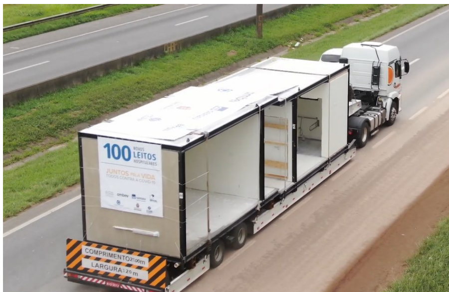
Figura 38 – Transporte dos módulos até o canteiro de obra
