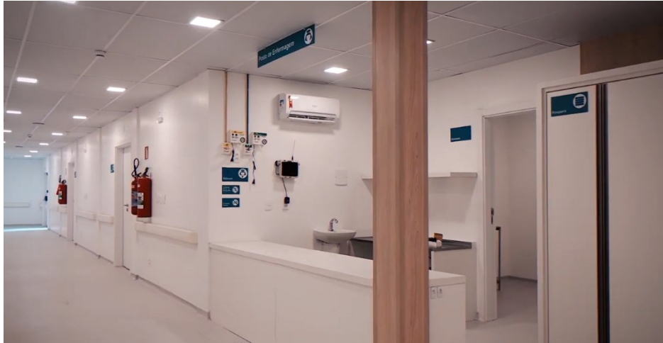
Figura 43 – Acabamento interno do hospital finalizado
