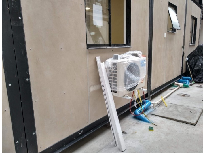
Figura 41 – Instalação dos condensadores no canteiro de obra
