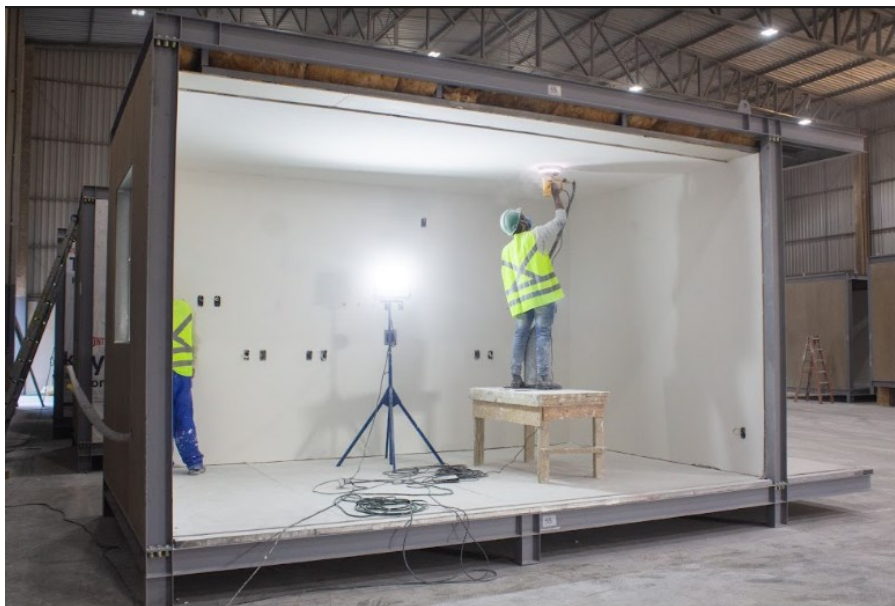
Figura 35 – Execução de emassamento das paredes internas
