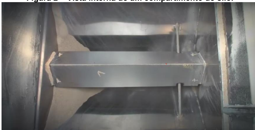
Figura 2 – Vista interna de um compartimento do silo.
