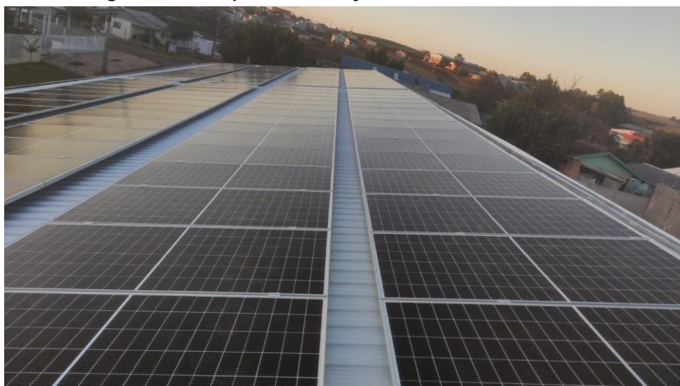
Figura 8 – Exemplo de instalação fotovoltaica em telhado.
