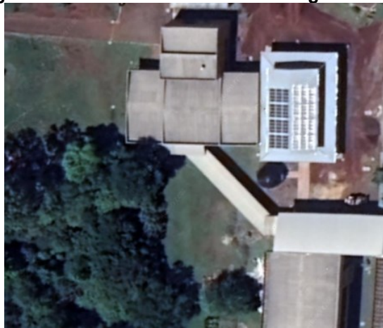
Fotografia 7 - Vista aérea do local do Lago Ornamental
