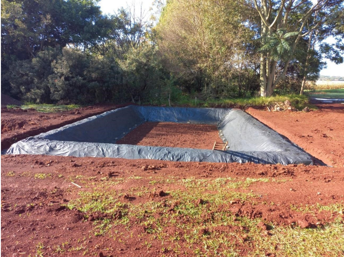
Fotografia 8 - Escavação do Lago e valetas para a ancoragem das mantas
