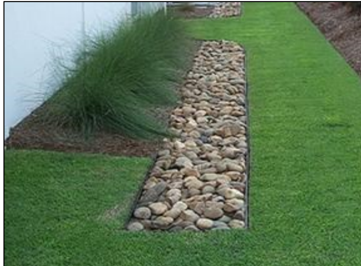
Figura 12 - Exemplo de trincheira de infiltração.
