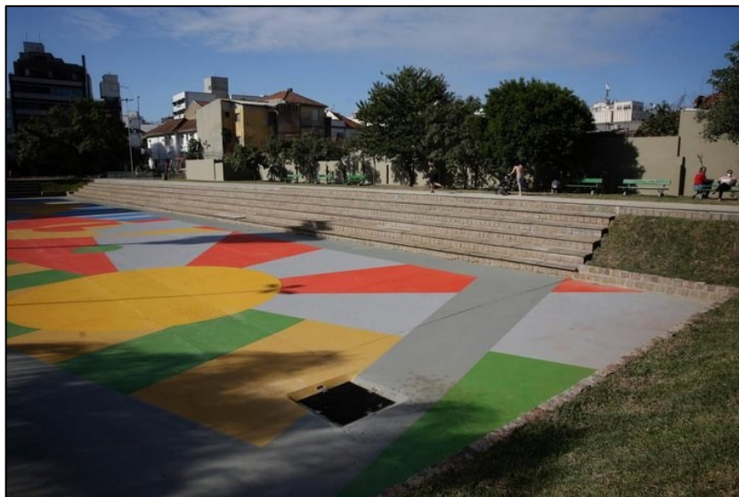
Figura 19 - Exemplo de bacia de detenção a céu aberto na Praça Júlio Andreatta.
