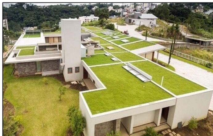
Figura 14 - Exemplo de telhado verde.
