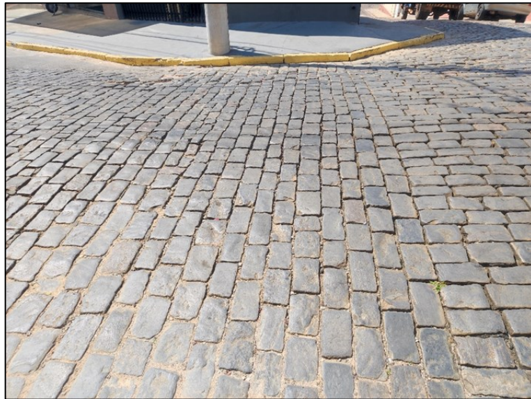
Fotografia 1 - Exemplo de pavimento composto por paralelepípedo.
