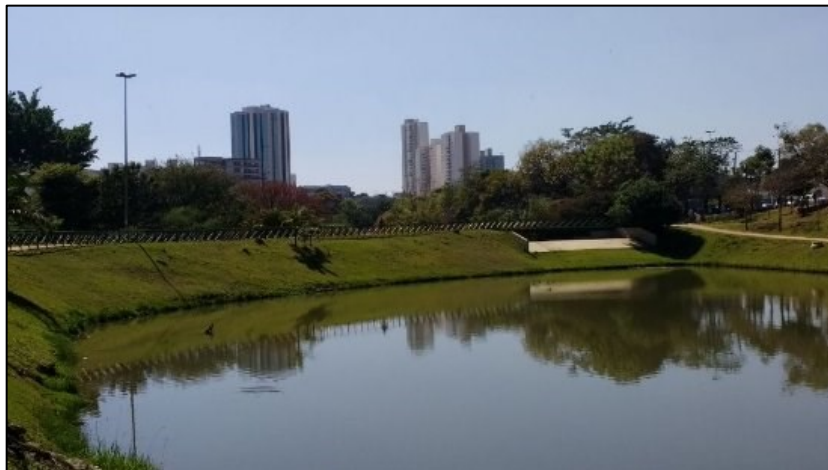
Figura 18 - Exemplo de reservatório de retenção localizado no Parque Campolim.
