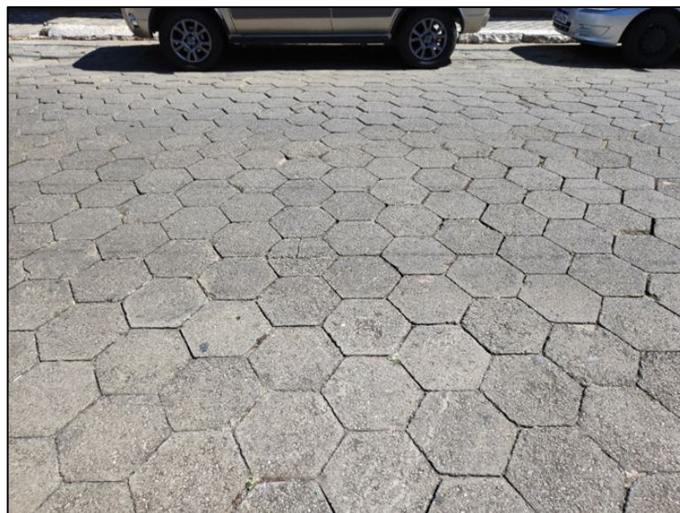
Fotografia 2 - Exemplo de pavimento composto por bloco de concreto sextavado.
