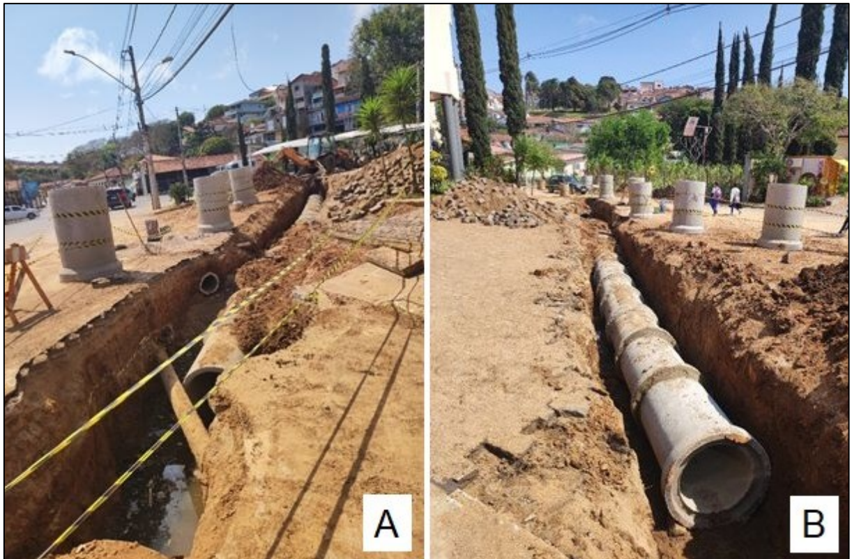
Fotografia 4 - Obras de drenagem realizadas na região do cruzamento.
