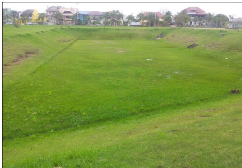
Figura 20 - Exemplo de bacia de detenção a céu no loteamento Ecoville.
