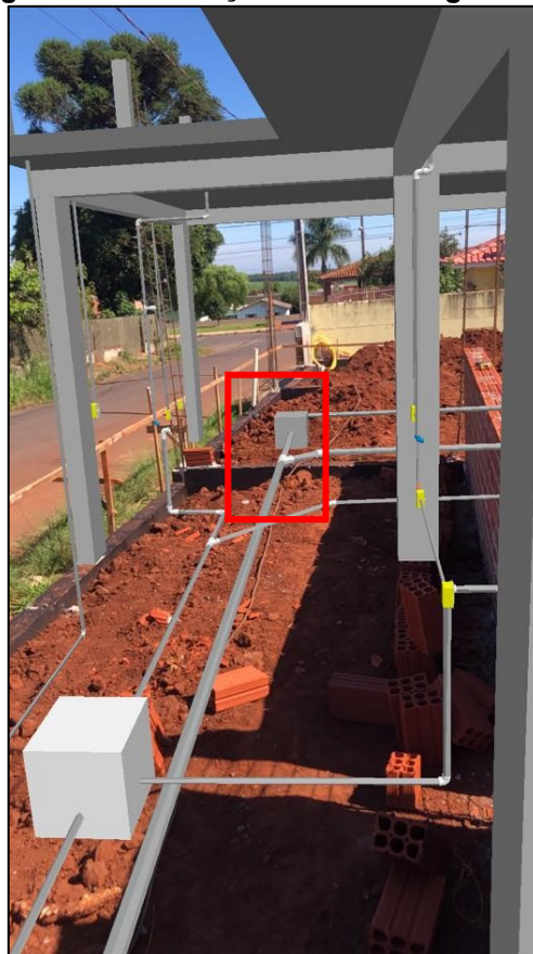
Fotografia 7 - Tubulação dentro da viga baldrame
