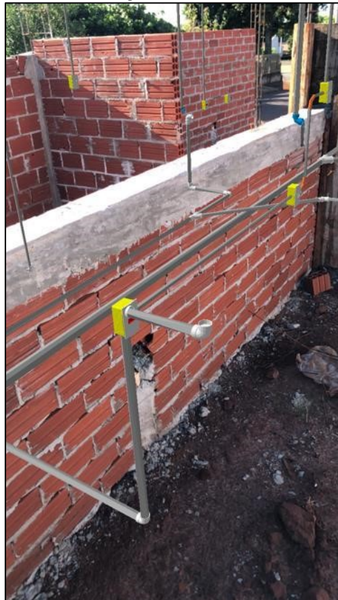
Fotografia 6 - Tubulação saindo de dentro da tomada
