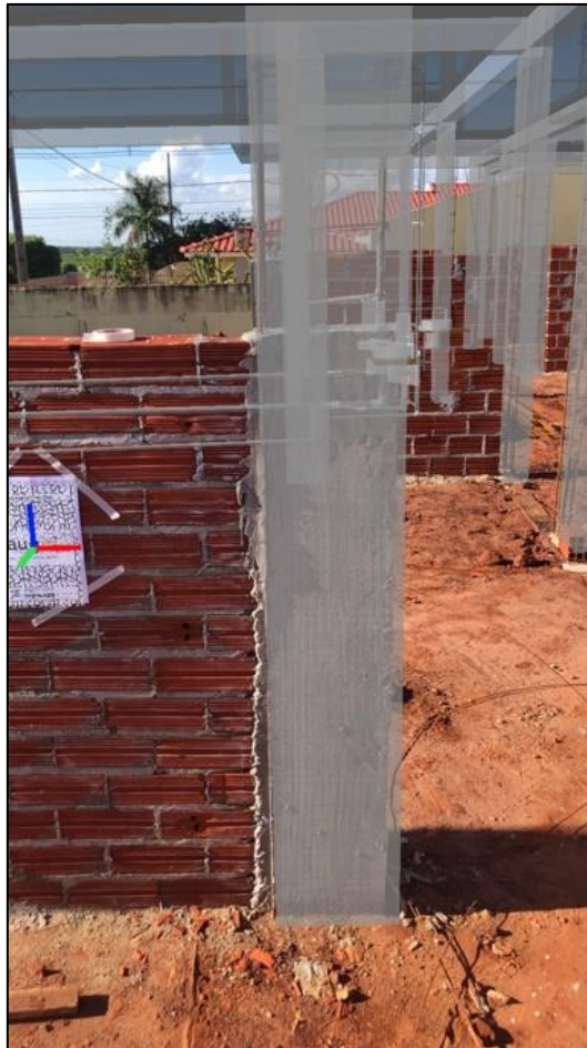
Fotografia 3 - Pilar em realidade aumentada deslocado 5cm
