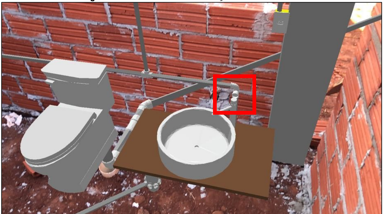
Fotografia 5 - Altura errada da tubulação do banheiro social
