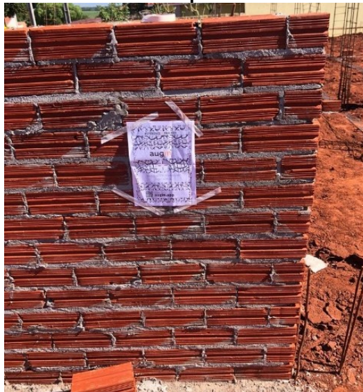
Fotografia 1 - Reference Tracker posicionado no canteiro de obra
