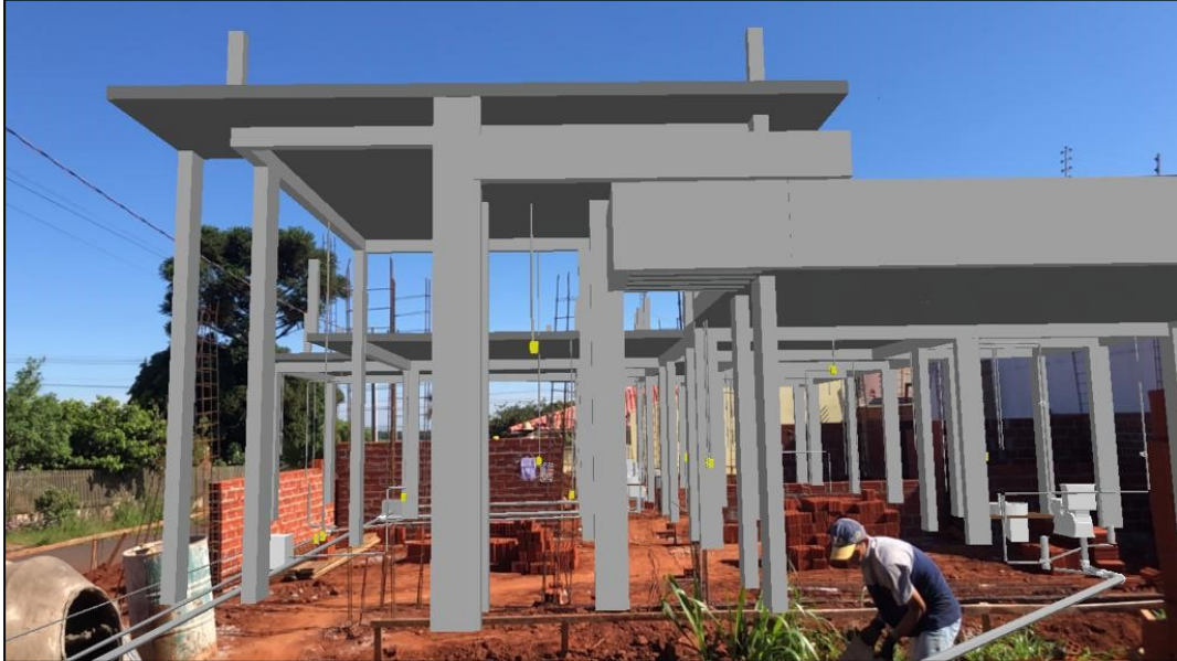
Fotografia 2 - Projetos complementares em realidade aumentada no canteiro de obra
