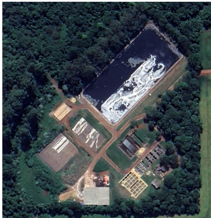
Figura 11 – Vista aérea da ETE km 119
