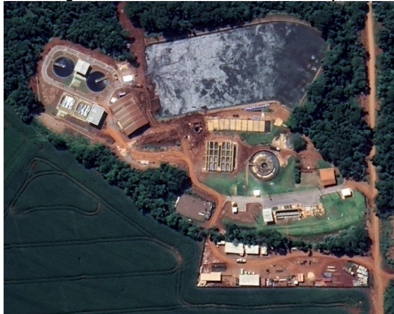
Figura 10 – Vista aérea da ETE Rio do Campo
