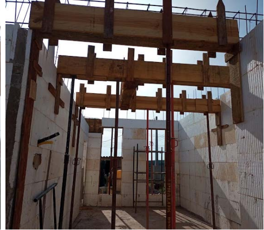
Figura 20b - Caixaria viga.
