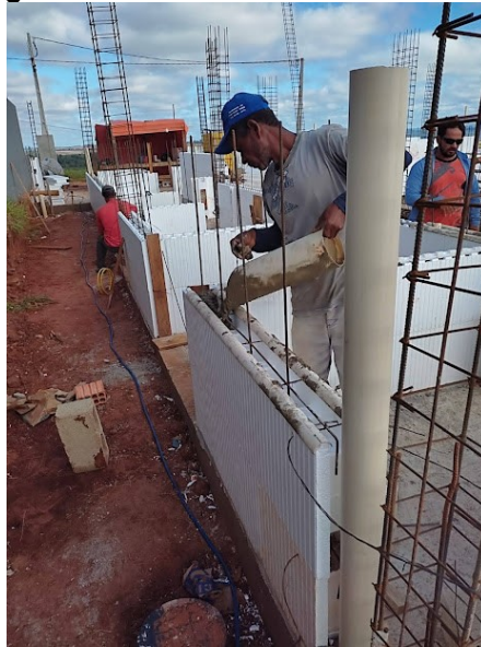
Figura 17 - Preenchimento das fôrmas.
