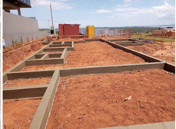
Figura 9b - Viga baldrame finalizada.
