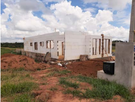
Figura 2a - Obra B.
