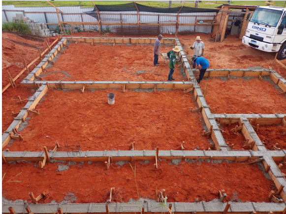
Figura 9a - Baldrame concretado.
