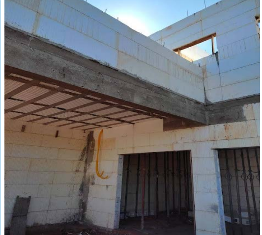
Figura 21b - Viga e laje.
