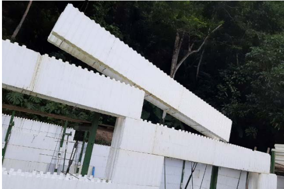
Figura 7a - ICF encaixe.
