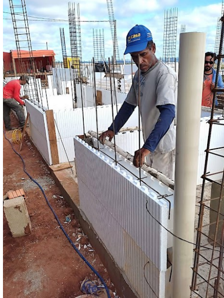
Figura 16 - Proteção das fôrmas.
