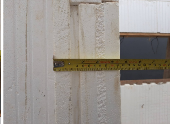
Figura 12b - Espessura 12cm.
