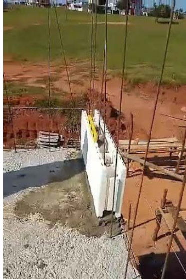
Figura 14 - Bloco locado.
