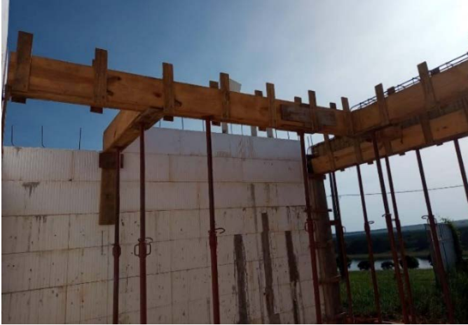
Figura 20a - Caixaria viga.
