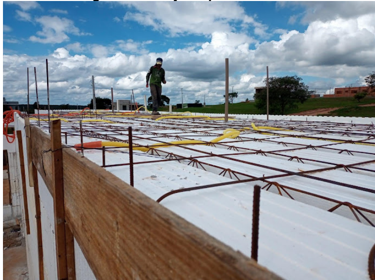
Figura 22b - Laje de piso Obra E.
