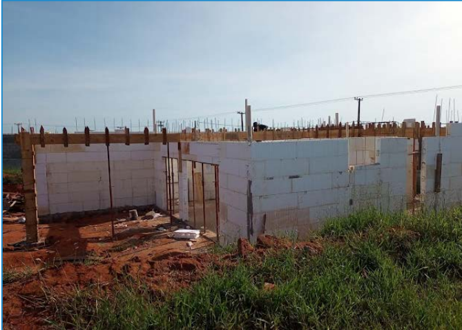
Figura 21a - Caixaria pilar e viga.
