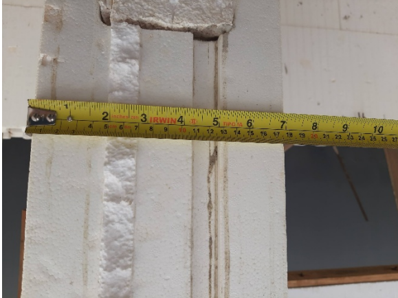
Figura 12a - Espessura 18cm.
