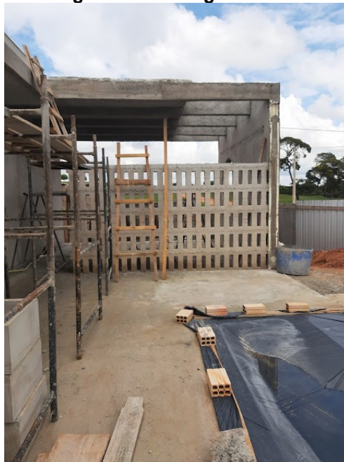
Figura 23 - Cobogó Obra A.
