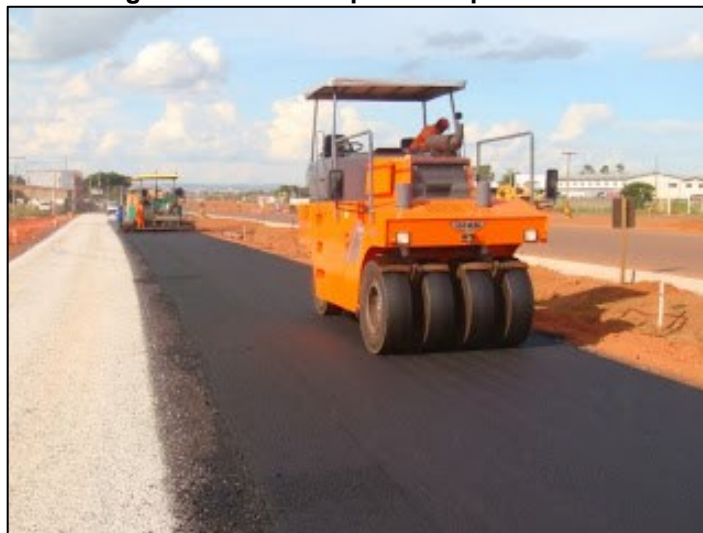
Figura 8 - Rolo compactador pneumático
