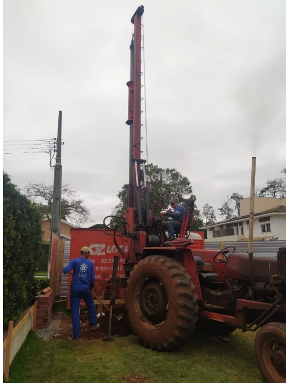
Fotografia 2 – Execução da perfuração das estacas
