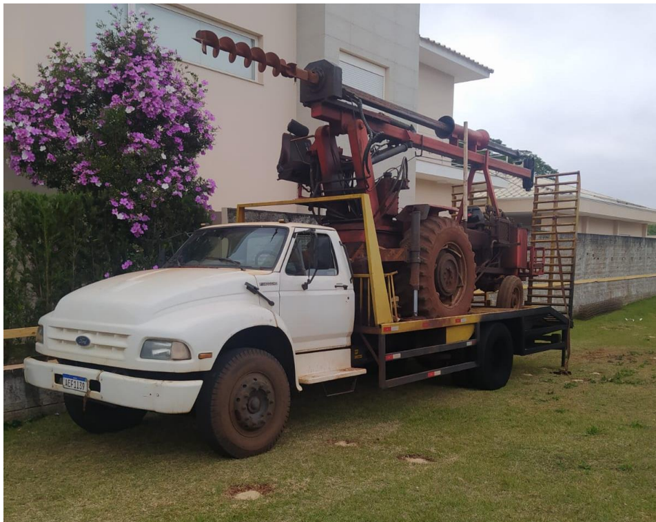
Fotografia 1 – Caminhão com perfuratriz hidráulica utilizada na perfuração das estacas
