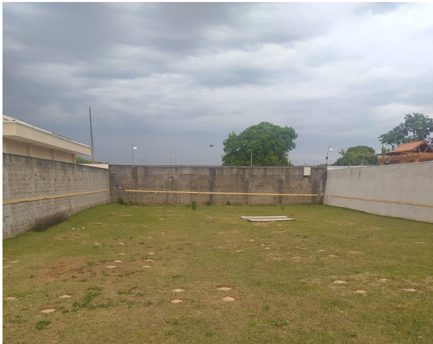
Fotografia 3 – Terreno com locação das estacas
