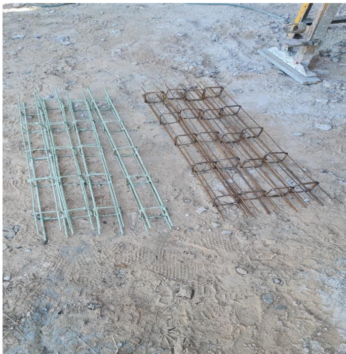
Figura 22: Armadura tratada com protetor de armadura e armadura sem tratamento.
