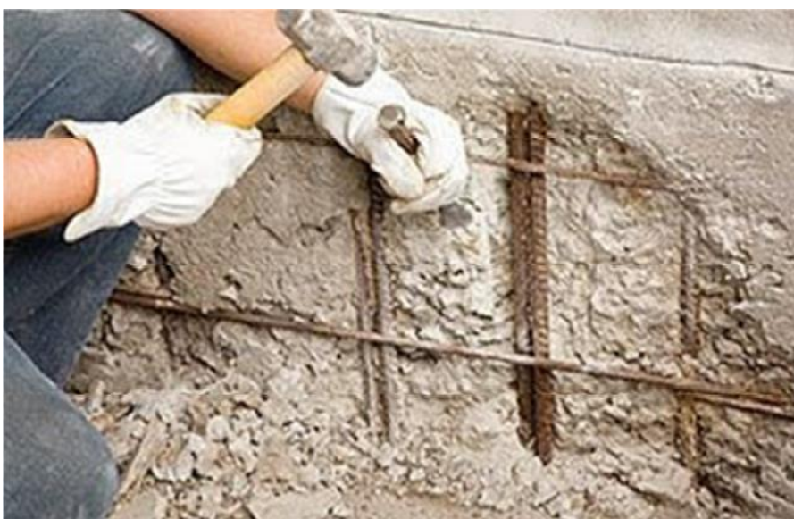
Figura 12: Remoção do concreto com uso de martelo e talhadeira
