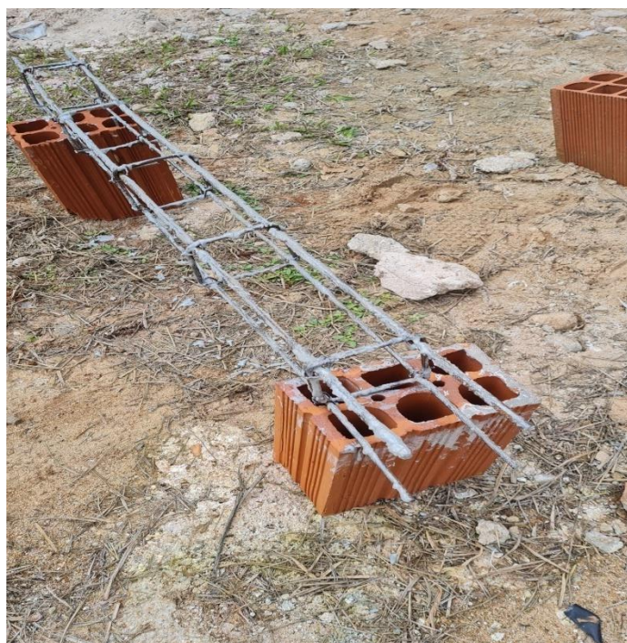
Figura 25: Armadura tratada com adesivo estrutural.
