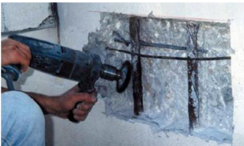
Figura 15: Remoção de produtos da corrosão com lixadeira elétrica
