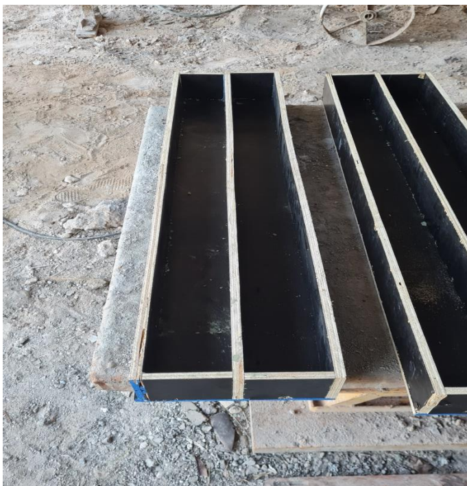
Figura 26: Forma para concretagem das vigas.
