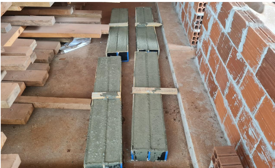
Figura 28: Vigas concretadas.
