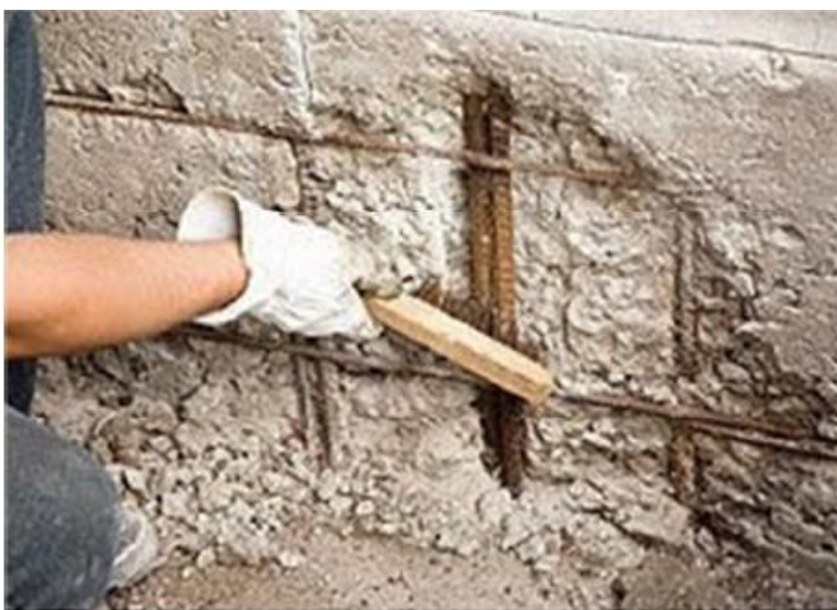
Figura 13: Remoção de produtos da corrosão com escova de cerdas de aço
