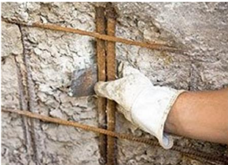
Figura 14: Remoção de produtos da corrosão com lixa manual
