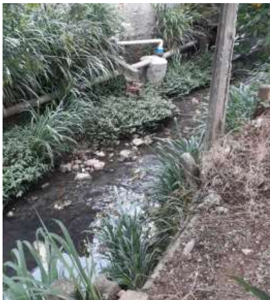
Figura 17 - Assentamentos de tubulações de esgoto rentes às margens do rio dos Padilhas Fonte: Aatoria própria, 2021.
