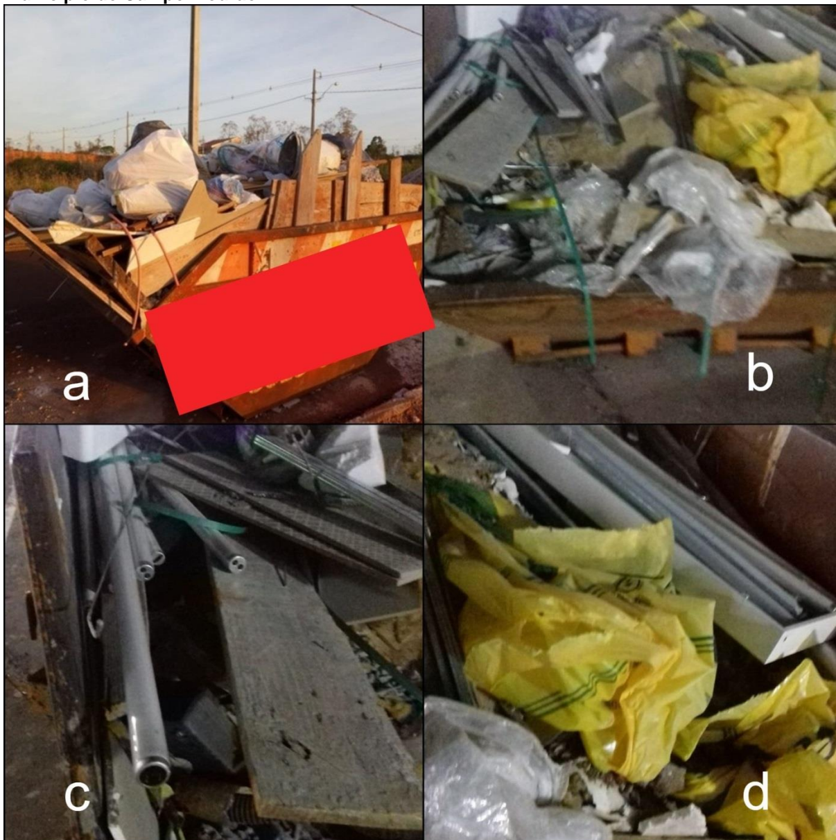
Figura 3 – Caçambas para acondicionamento dos RCC encontradas nas vias públicas do município de Campo Mourão-PR.
