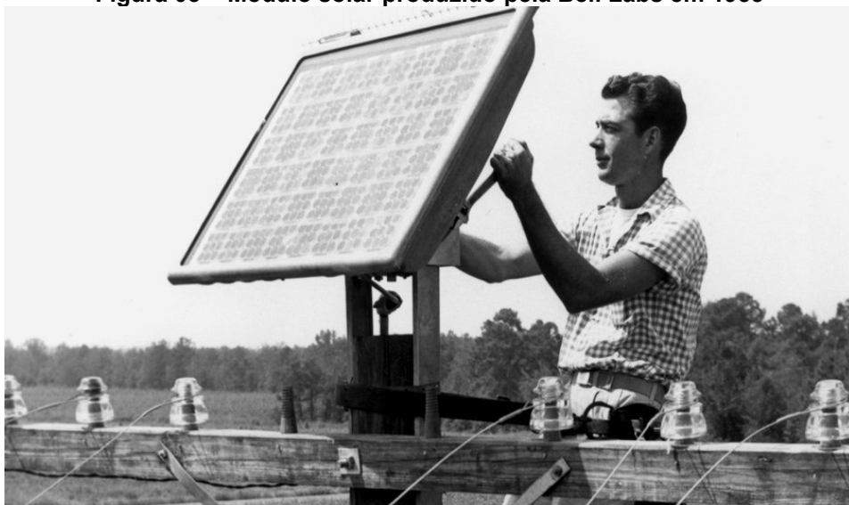
Figura 03 – Módulo solar produzido pela Bell Labs em 1955
