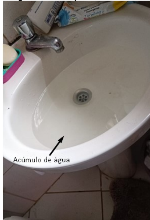
Fotografia 3 – Entupimento de Lavatório
