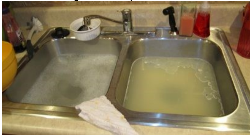
Figura 10 – Entupimento de Pia
