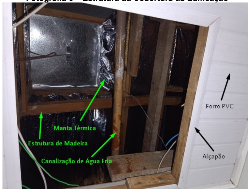
Fotografia 6 – Estrutura da Cobertura da Edificação
