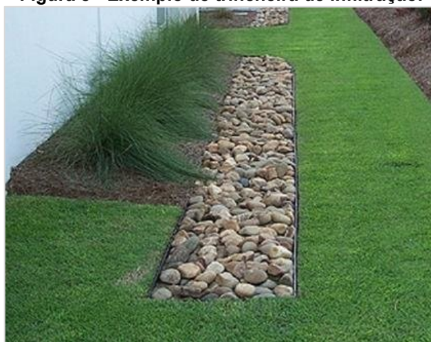
Figura 8 - Exemplo de trincheira de infiltração.
