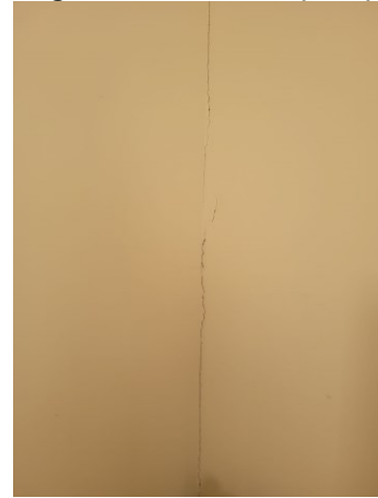
Figura 10 – Fissura (Fi=1)
