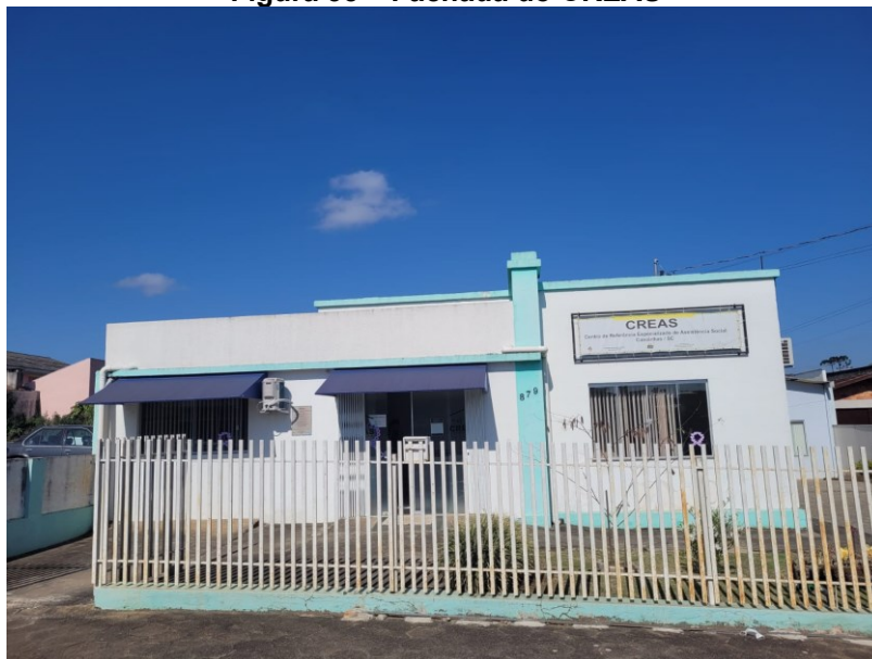
Figura 35 – Fachada do CREAS
