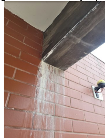
Figura 45 – Carbonatação (Fi=1)
