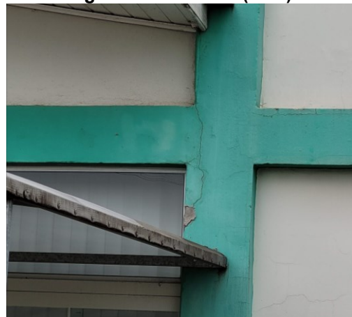
Figura 17 – Fissura (Fi=2)
