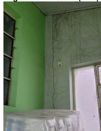
Figura 19 – Fissura (Fi=2)
