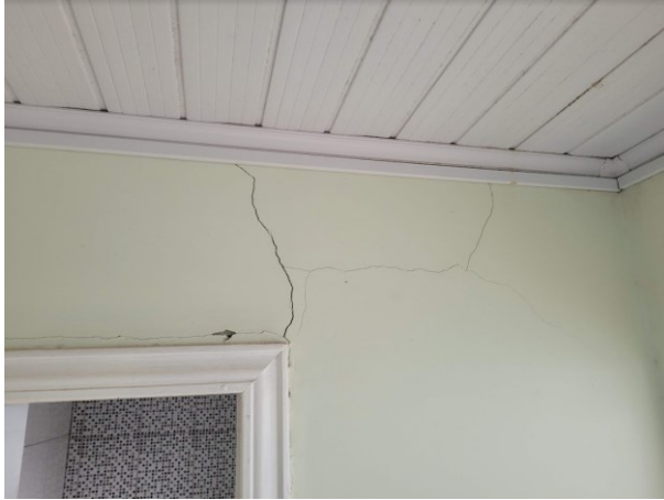
Figura 37 – Fissuras (Fi=2)
