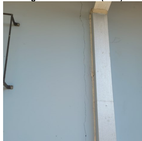
Figura 12 – Fissura (Fi=2)
