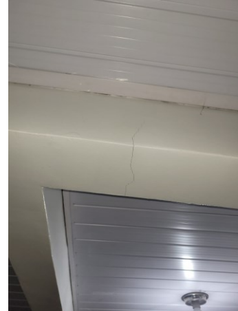
Figura 26 – Fissura (Fi=2)
