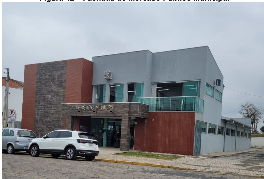
Figura 42 – Fachada do Mercado Público Municipal
