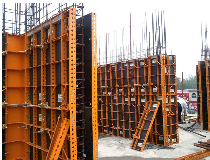
Figura 1 - Fôrmas de paredes de concreto
