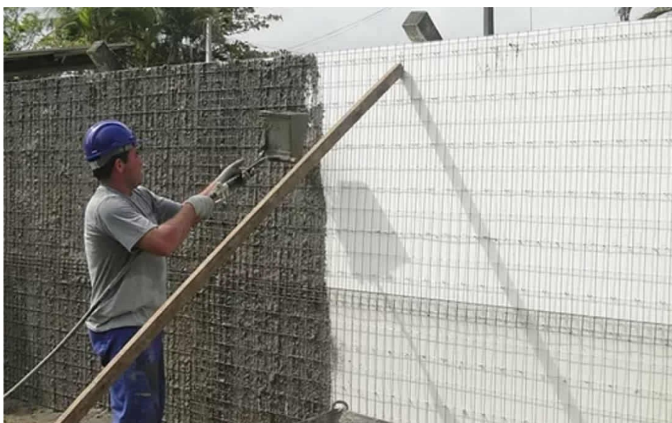
Figura 9 - Revestimento de painéis em EPS
