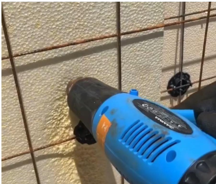
Figura 7 - Pistola de ar quente para abrir sulcos no painel EPS
