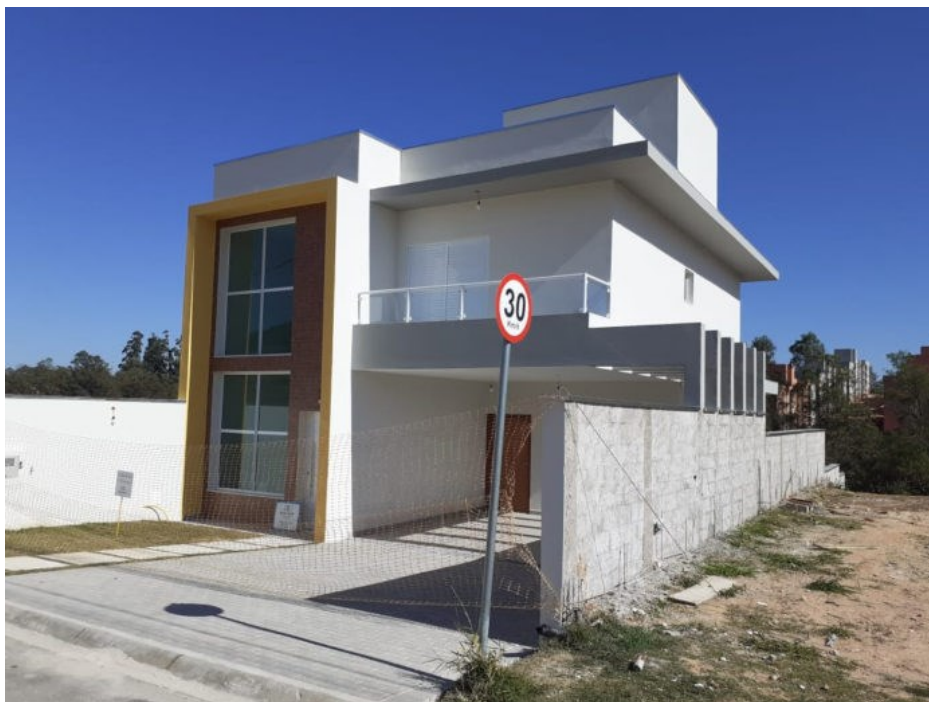
Figura 10 - Residência unifamiliar executada com painéis EPS
