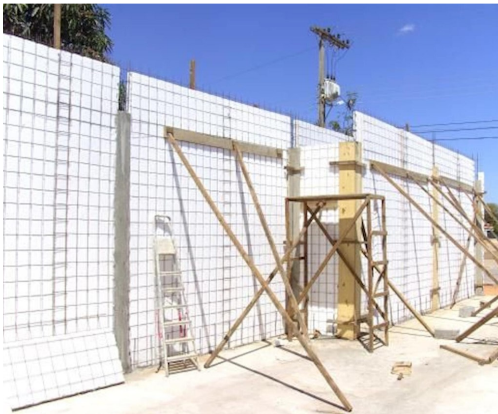
Figura 4 - Montagem de painéis em EPS
