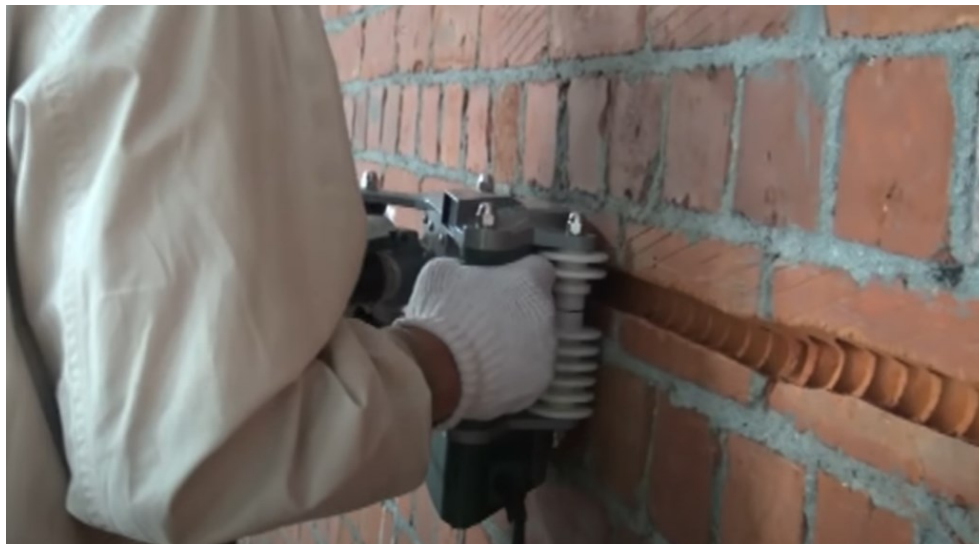
Figura 15 - Execução de sulcos para passagem de tubulação
