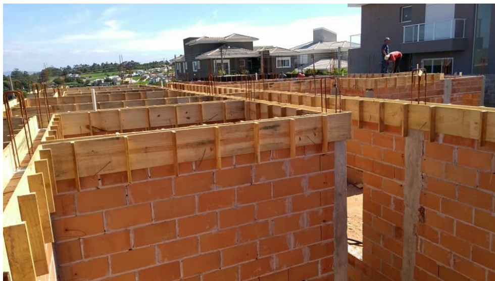
Figura 13 – Fôrmas de vigas
