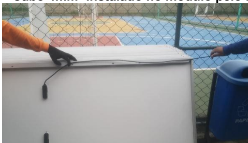
Figura 24 - Cabo 4mm 2 instalado no módulo pelo fabricante.
