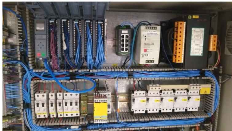
Figura 41 – Organizando cabos no painel elétrico.
