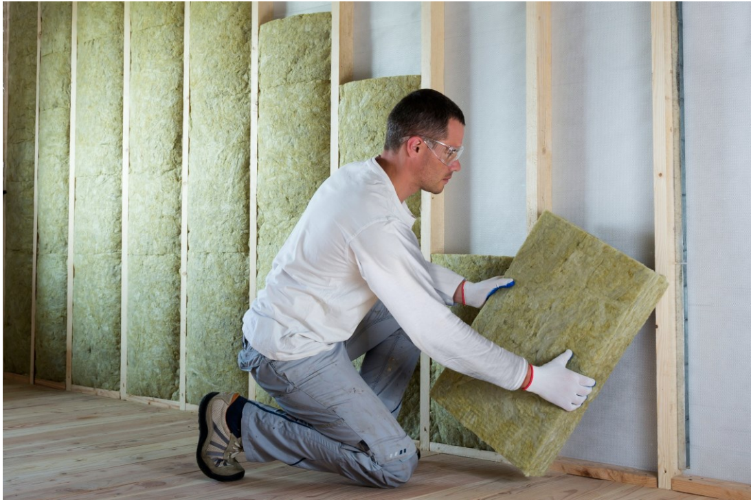
Figura 9 - Instalação da lã de rocha Rockwool
