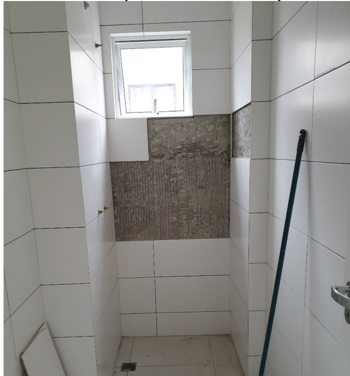
Figura 8 - Banheiro de um apartamento do edifício que sofreu retrabalho
