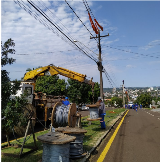
Figura 36 - Detalhe das bobinas prontas para realização do lançamento dos condutores
