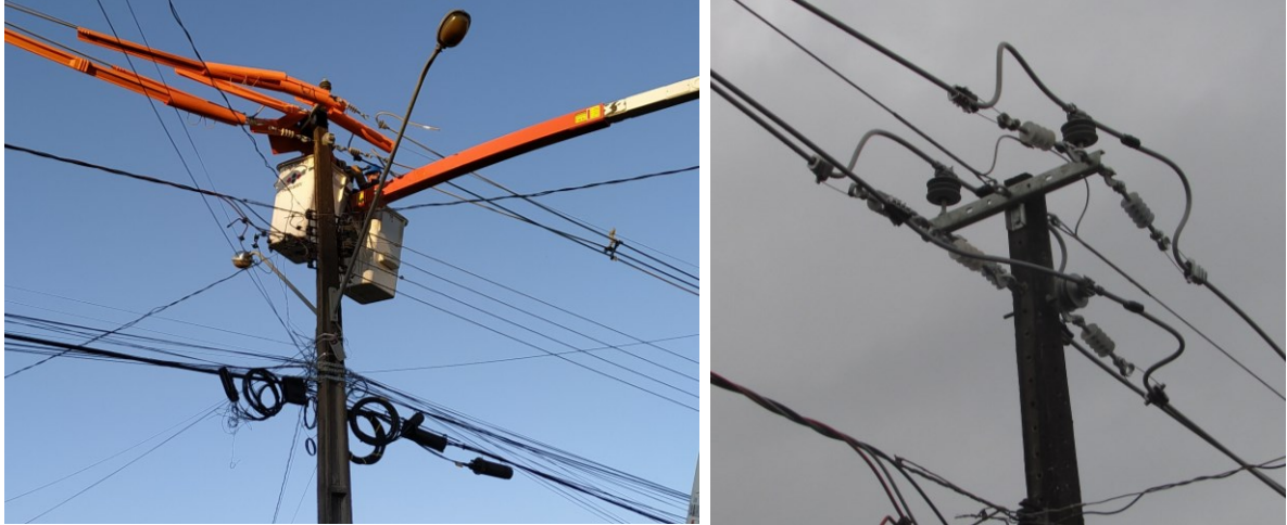
Figura 38 - Equipe de linha viva realizando a ligação dos condutores e estrutura após ligação
