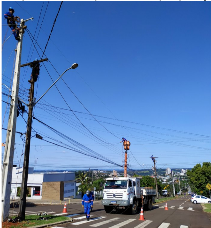
Figura 37 - Eletricistas posicionados nos postes e cestos para passagem dos condutores
