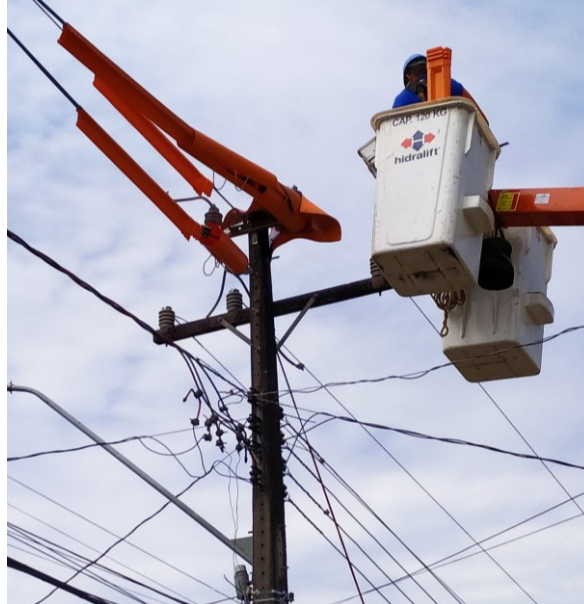
Figura 32 - Ponto próximo a chave-fusível aberto pela linha viva
