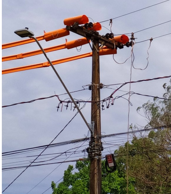
Figura 34 - Aterramento temporário em poste com circuito aberto pela linha viva
