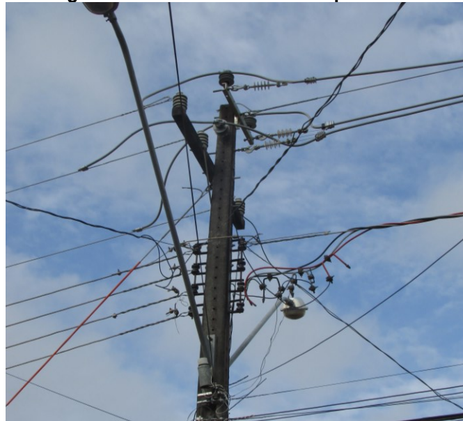
Figura 29 - Poste com estrutura provisória
