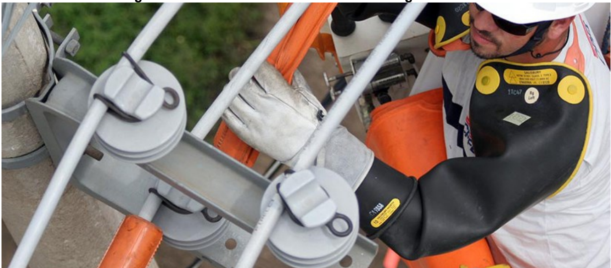
Figura 26 - Eletricista utilizando luvas e mangas isolantes
