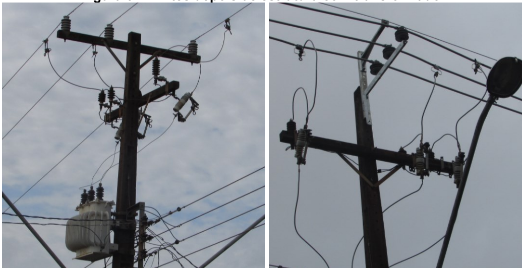
Figura 31 - Antes/depois de estrutura com transformador
