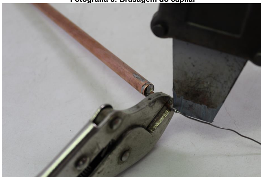
Fotografia 8: Brasagem do capilar
