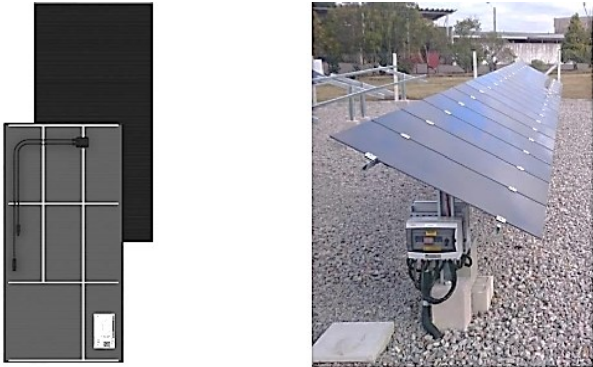
Figura 12 – Módulo e o painel fotovoltaico de CdTe
