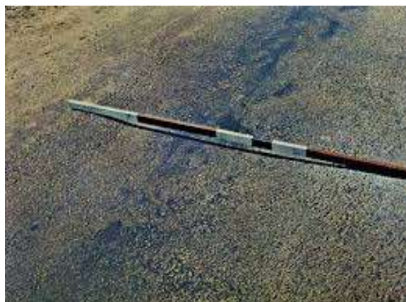
Figura 9 – Afundamento local.
