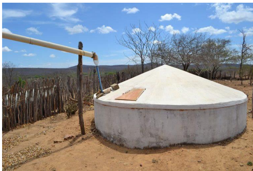
Figura 2 - Cisterna de placas de concreto de 16.000 L construída pelo P1MC. Fonte: Brasil, Governo Federal, 2020
