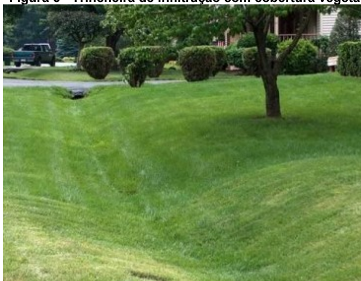
Figura 6 - Trincheira de infiltração com cobertura vegetal
