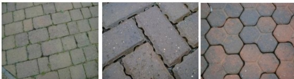
Figura 1 - Exemplos de revestimentos usados em pavimentos permeáveis
