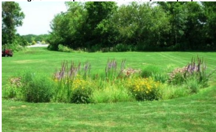
Figura 12 - Dispositivo de biorretenção em parque
