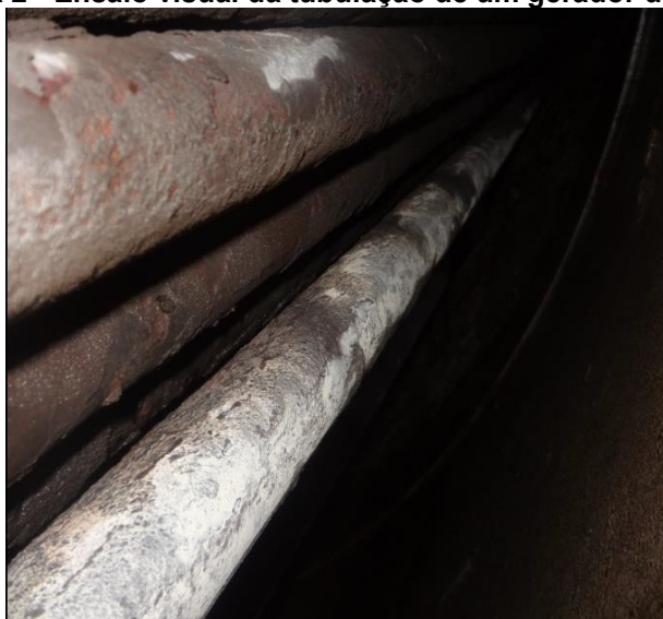
Figura 2 - Ensaio visual da tubulação de um gerador de vapor
