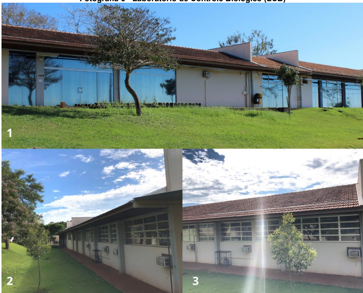
Nota: 1: vista da frente (F) do prédio. 2 e 3: vista da parte de trás (A) do prédio. Fonte: Autoria própria (2022)
