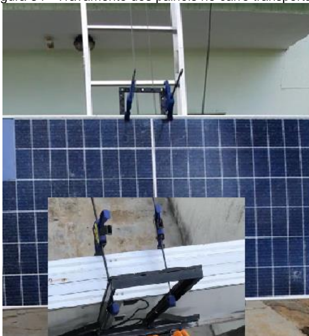
Figura 34 - Travamento dos painéis no carro transportador
