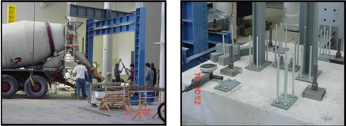
Figura 21 - Preparação das sapatas e barras rosqueadas
