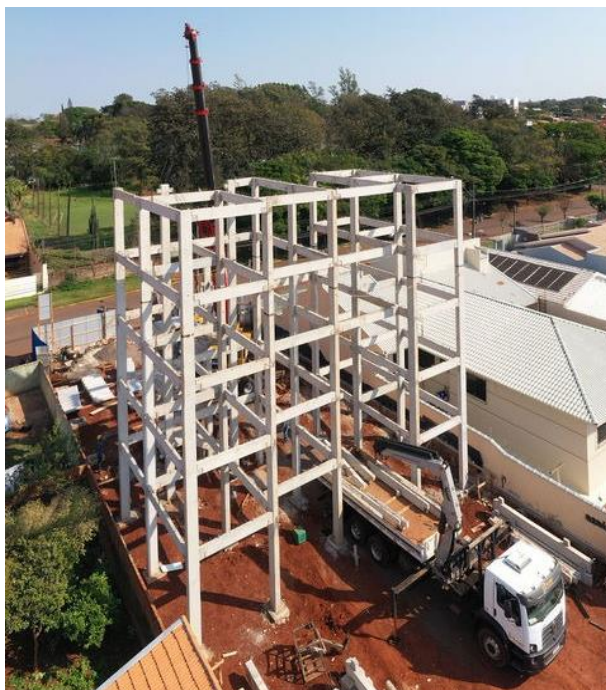
Fotografia 1 - Montagem de uma estrutura pré-fabricada
