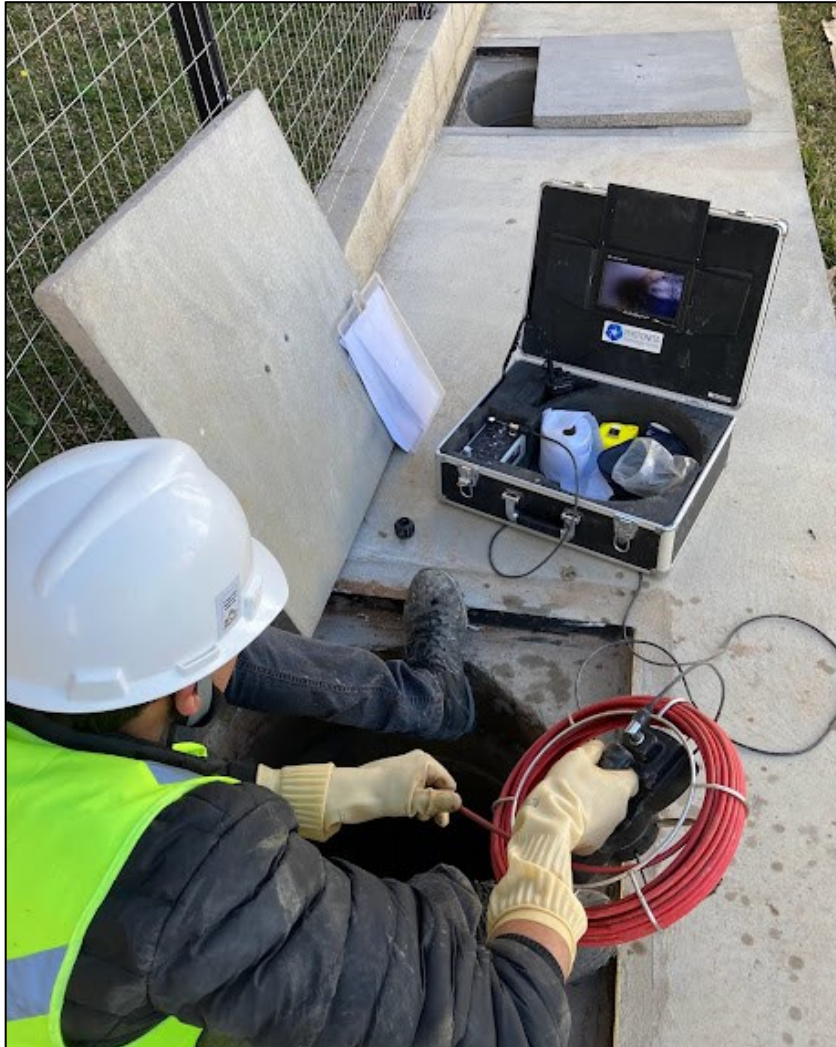
Fotografia 7 – Vídeo-inspeção com uso do endoscópio industrial.
