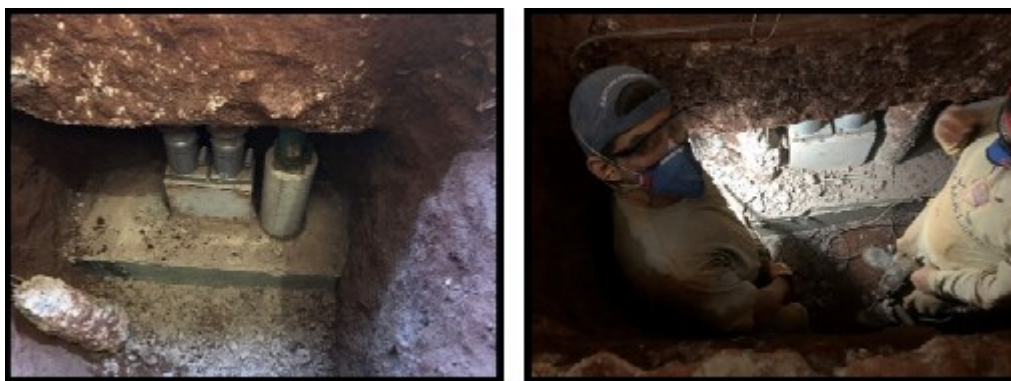
Figura 7 - Realização do reforço com estaca mega
