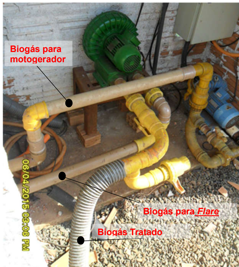
Figura 28 – Detalhe da ligação SPB2 ao Flare
