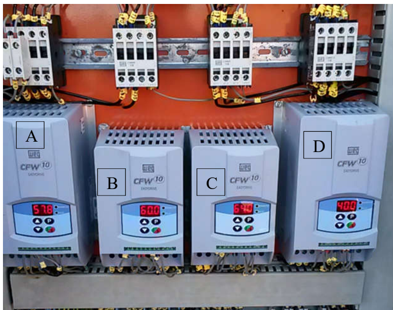
Figura 18 – Inversores de frequência do SPB3
