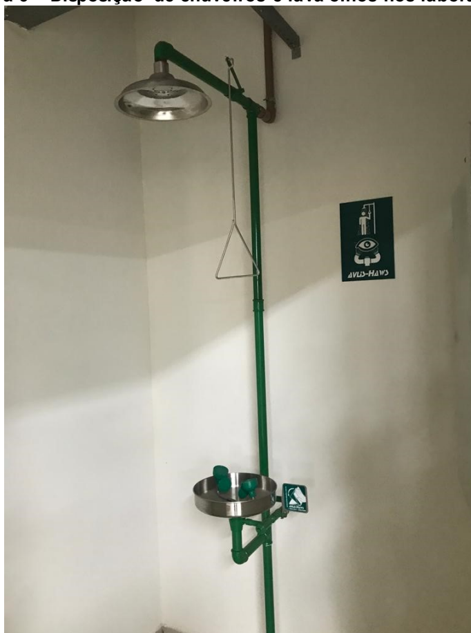
Figura 6 – Disposição de chuveiros e lava olhos nos laboratórios
