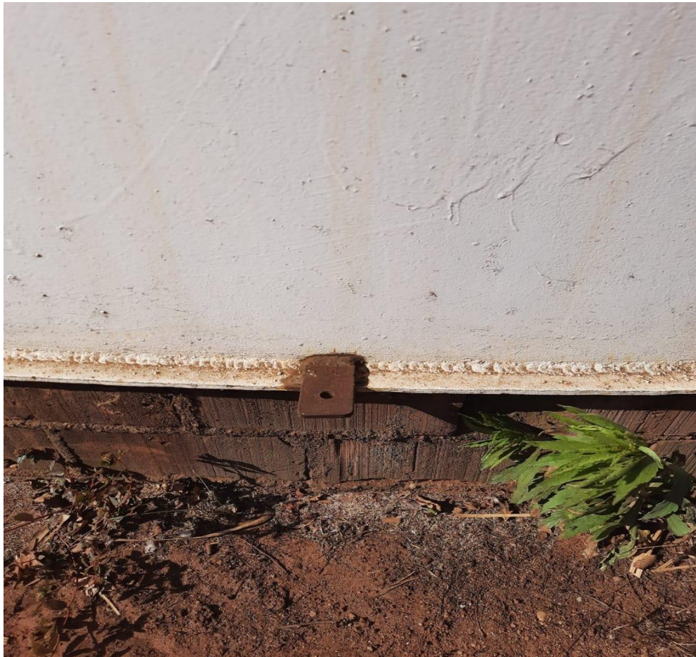
Figura 15 – Chapas de ferros nas estruturas das dornas de armazenagem
