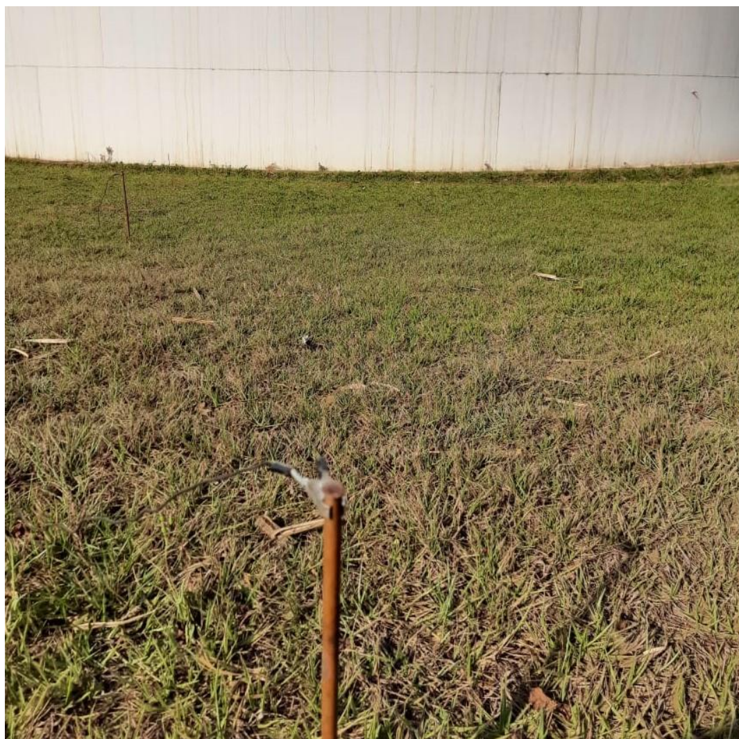
Figura 17 - Hastes de cobre do terrômetro fixas no solo
