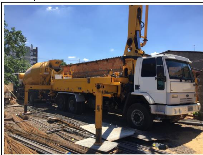
Figura 1 - Acoplamento entre caminhão betoneira e autobomba de concreto
