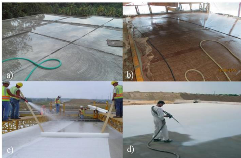
Figura 8: a) cura por alagamento. b) cura por aspersão. c) cura com mantas úmidas e d) cura química.
