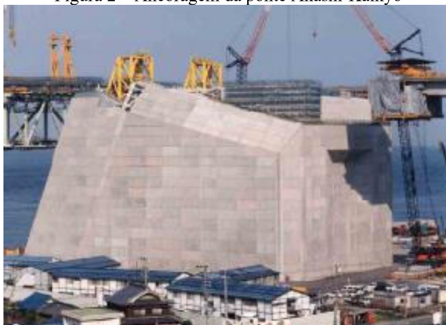
Figura 2 – Ancoragem da ponte Akashi-Kaikyo
