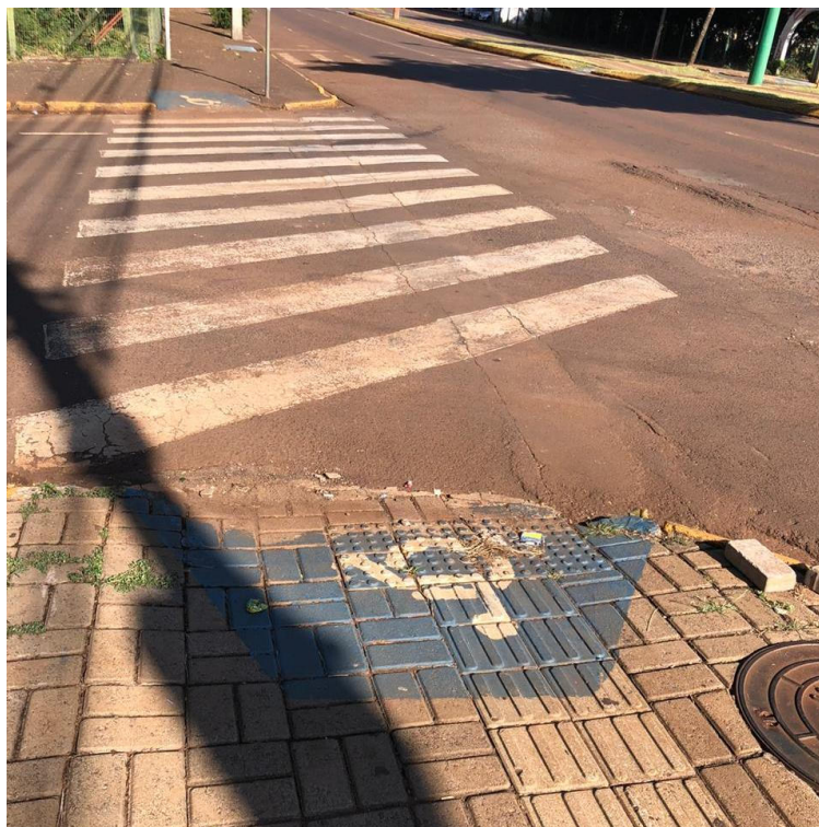
Figura 9 - Rampa de acesso Fonte: Do autor (2020).
