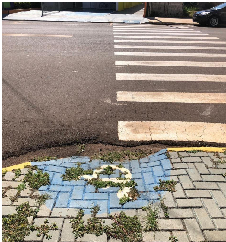
Figura 8 - Rampa de acesso Fonte: Do autor (2020).
