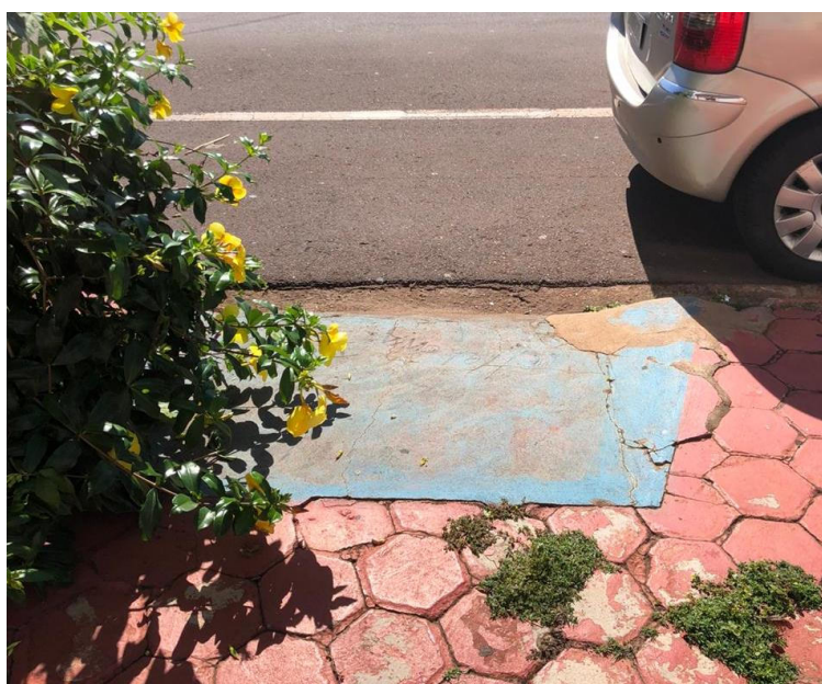
Figura 7 - Rampa de acesso Fonte: Do autor (2020).
