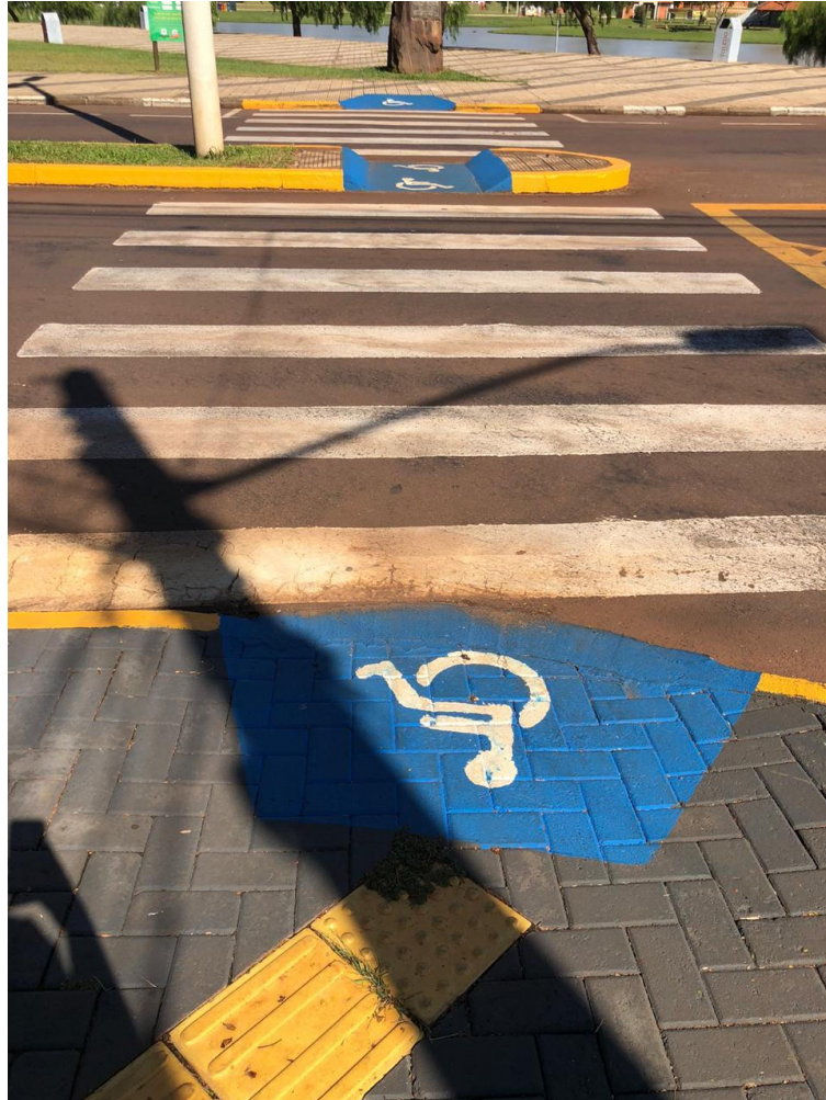
Figura 13 - Rampa de acesso Fonte: Do autor (2020).
