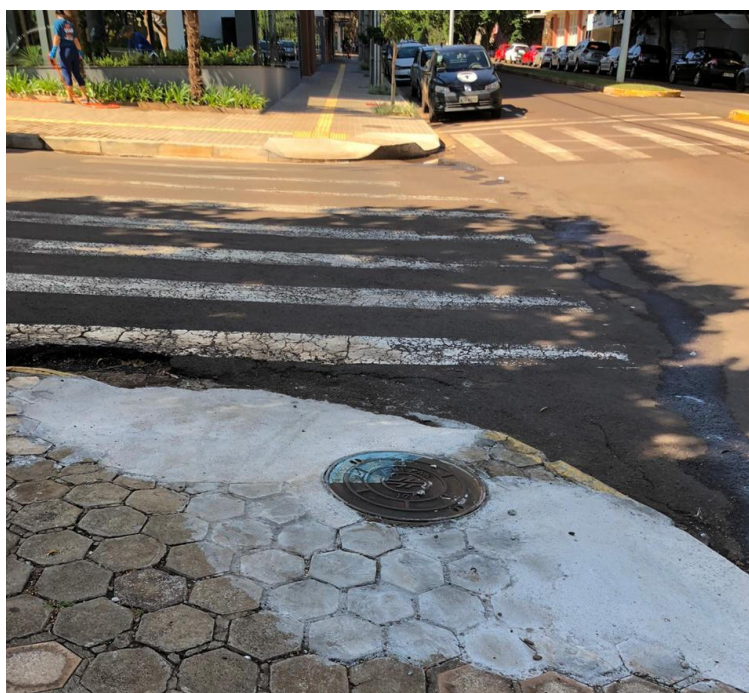
Figura 16 - Rampa de acesso Fonte: Do autor (2020).
