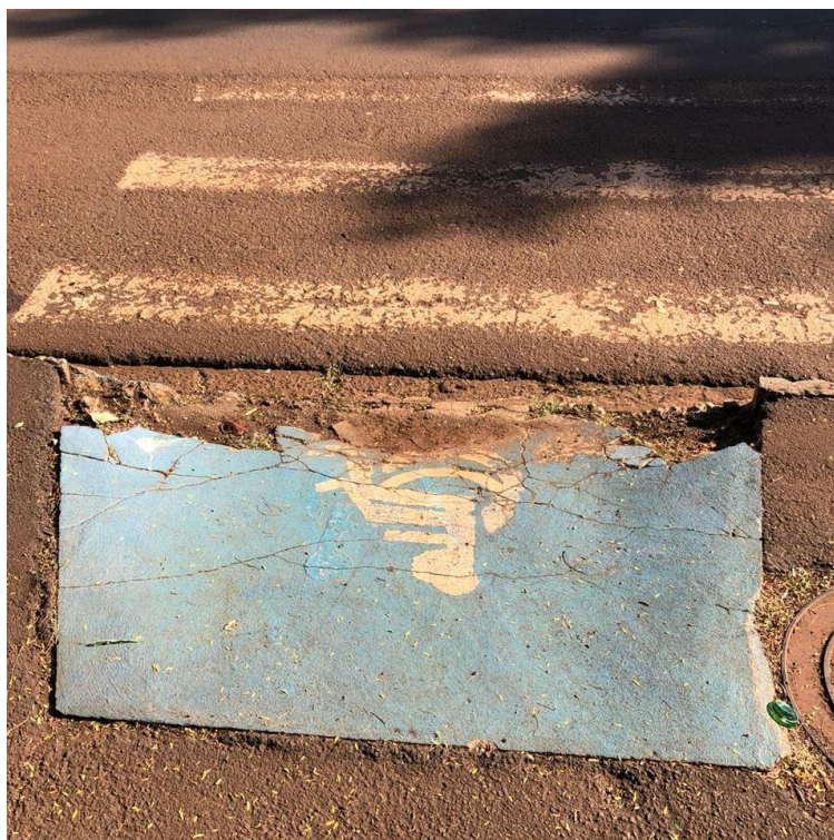
Figura 10 - Rampa de acesso Fonte: Do autor (2020).
