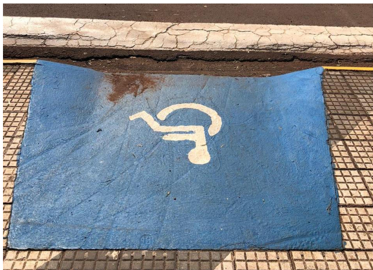
Figura 12 - Rampa de acesso Fonte: Do autor (2020).
