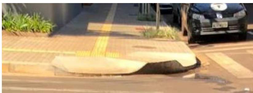
Figura 14 - Rampa de acesso Fonte: Do autor (2020).
