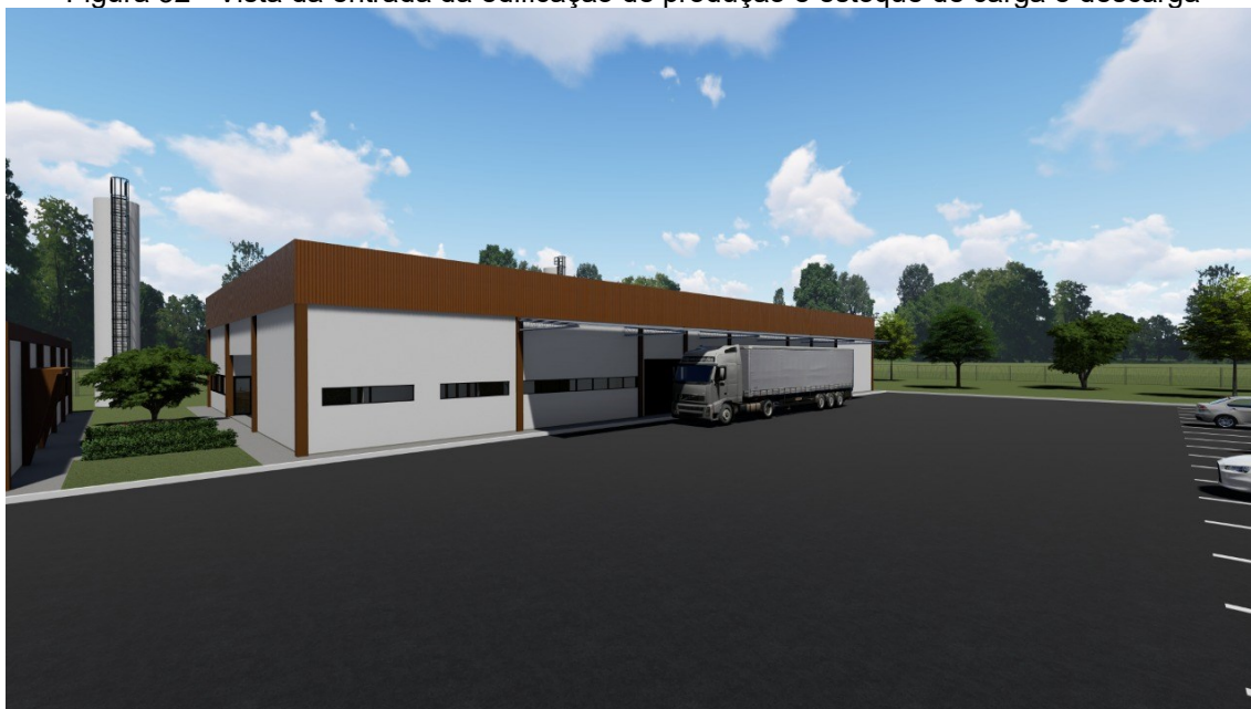
Figura 32 - Vista da entrada da edificação de produção e estoque de carga e descarga
