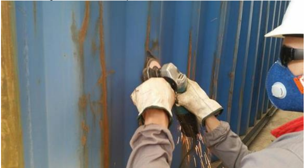
Figura 12 - Lixamento da parte externa do container
