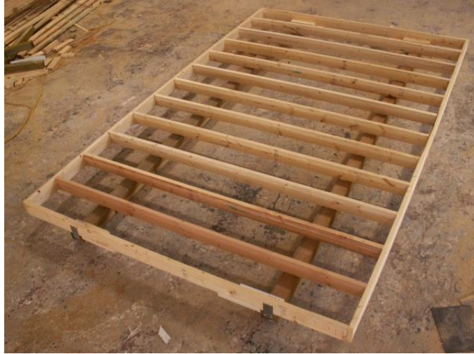
Figura 1 - Tablado sobre o qual a habitação será construída
