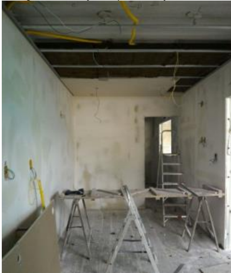
Figura 11 - Instalação das placas de drywall
