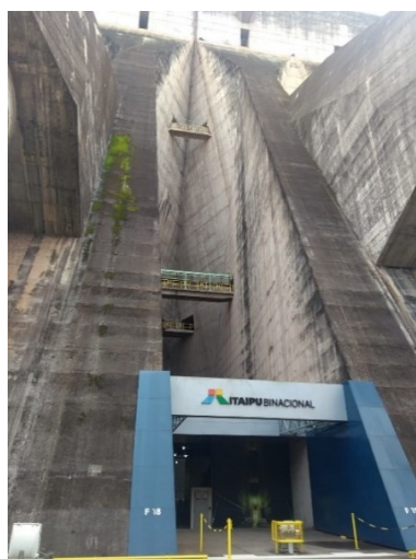
Figura 1 - Barragem Principal de Itaipu (Trecho F)
